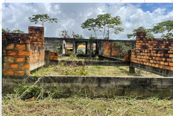
Figura 11 – Vista da creche inacabada
