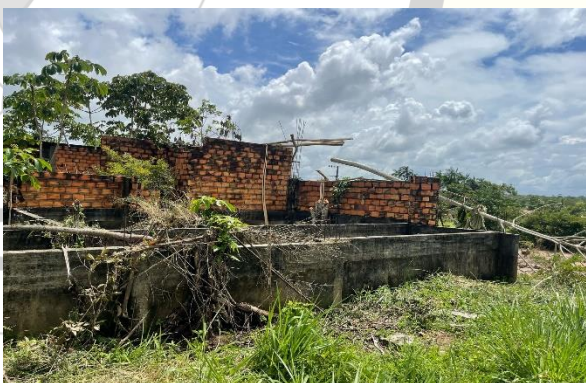
Figura 9 – Vista da creche inacabada
