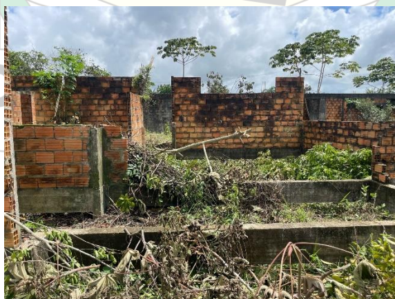
Figura 6 – Vista da creche inacabada
