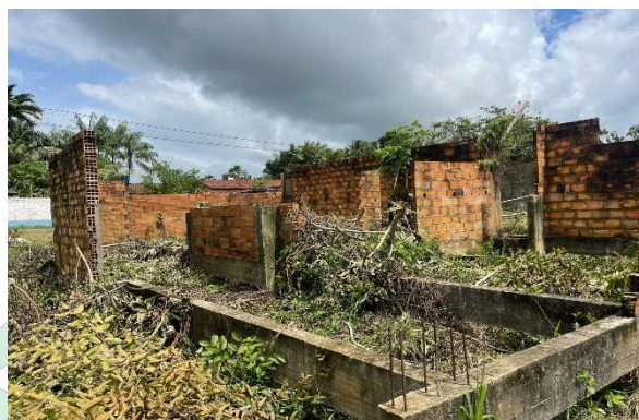
Figura 7 – Vista da creche inacabada
