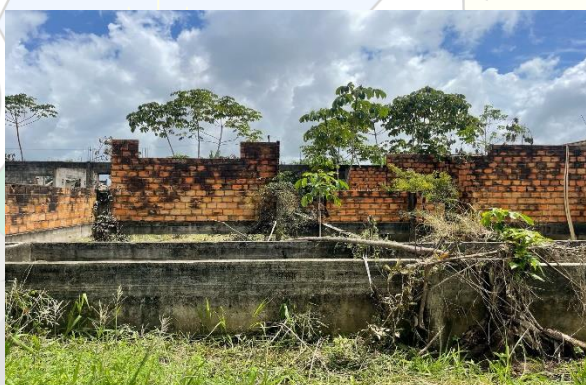
Figura 8 – Vista da creche inacabada
