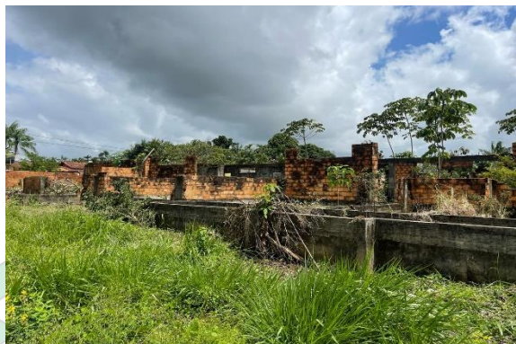
Figura 10 – Vista da creche inacabada
