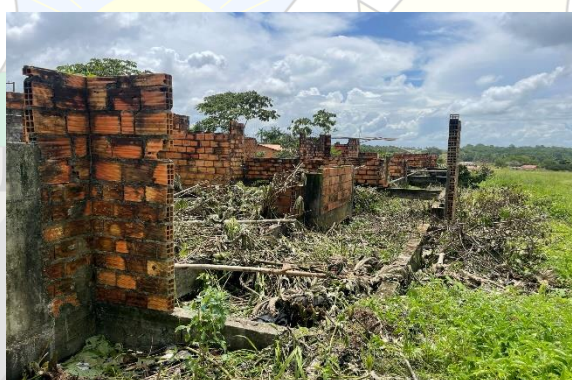
Figura 5 – Vista da creche inacabada
