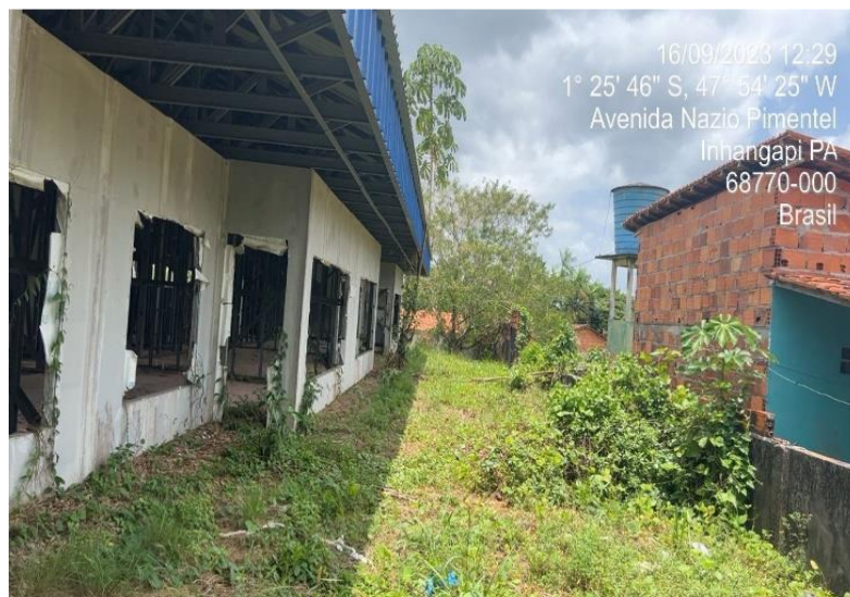
Figura 3 - Fachada externa lateral do bloco Pedagógico – placas de fechamento externo apresentando limos e expansão das placas inferior e sem diversas regiões, provocada por umidade percolante de fora para dentro.. Fonte: elaboração própria
