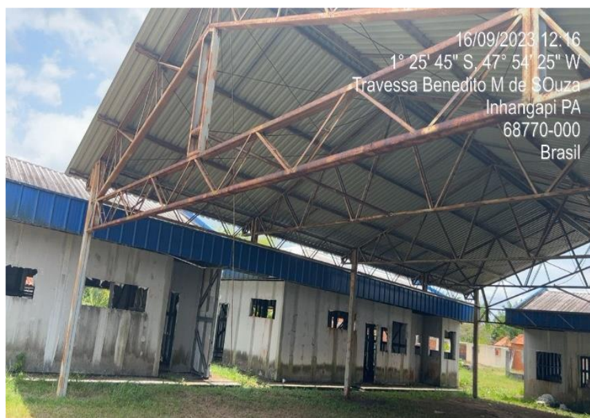
Figura 8 – vigas, pilares e tesouras estão expostos às intempéries. Fonte: elaboração própria.
