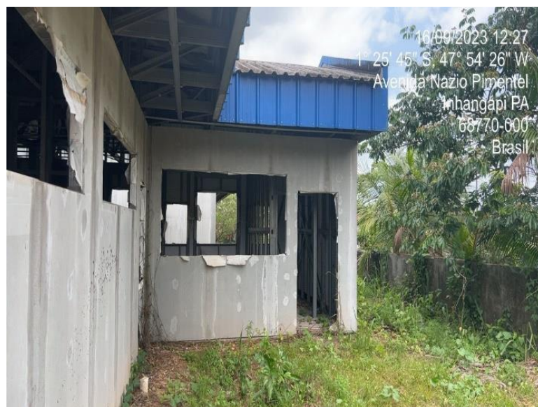
Figura 4 – Fachada externa lateral do bloco Pedagógico – placas de fechamento externo apresentando limos e expansão das placas inferior e sem diversas regiões, provocada por umidade percolante de fora para dentro. Fonte: elaboração própria
