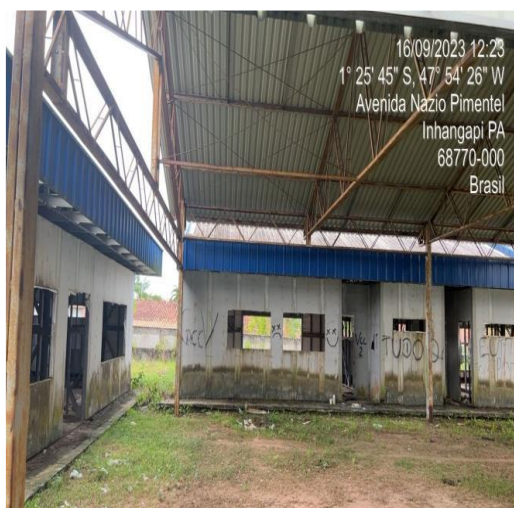
Figuras 19 e 20 – Não foram executadas as telhas translúcidas no pátio central, item este que consta como inconformidade no SIMEC.
