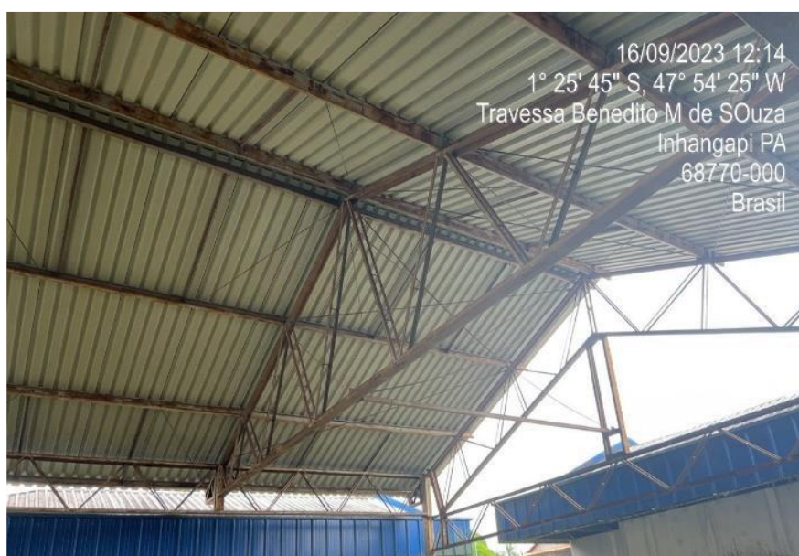
Figura 8 – vigas, pilares e tesouras estão expostos às intempéries. Fonte: elaboração própria.
