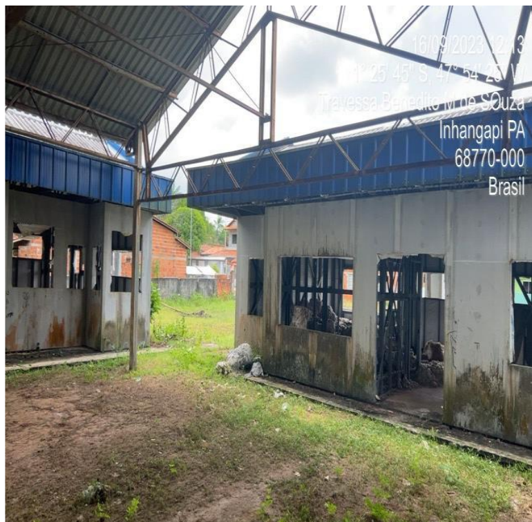
Figura 11 – vigas, pilares e tesouras estão expostos às intempéries. Fonte: elaboração própria.
