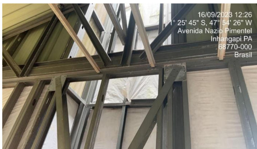
Figura 15 – Apresentam nos perfis superiores, para instalações dos Forros, pontos de corrosões, porém os mesmos não apresentam grandes riscos a estrutura. Fonte: elaboração própria.
