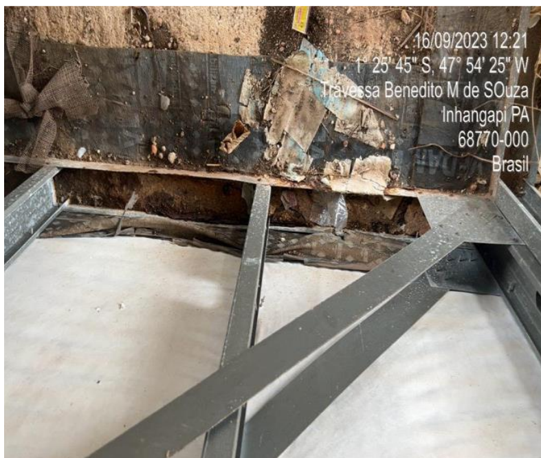
Figura 14 – perfis longitudinais em contatos com o radier em estado de corrosão.
