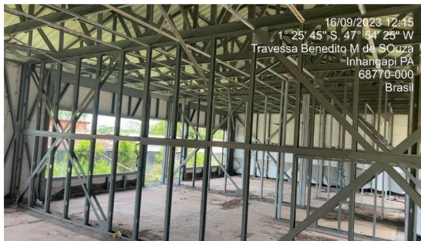
Figura 15 – Apresentam nos perfis superiores, para instalações dos Forros, pontos de corrosões, porém os mesmos não apresentam grandes riscos a estrutura. Fonte: elaboração própria.
