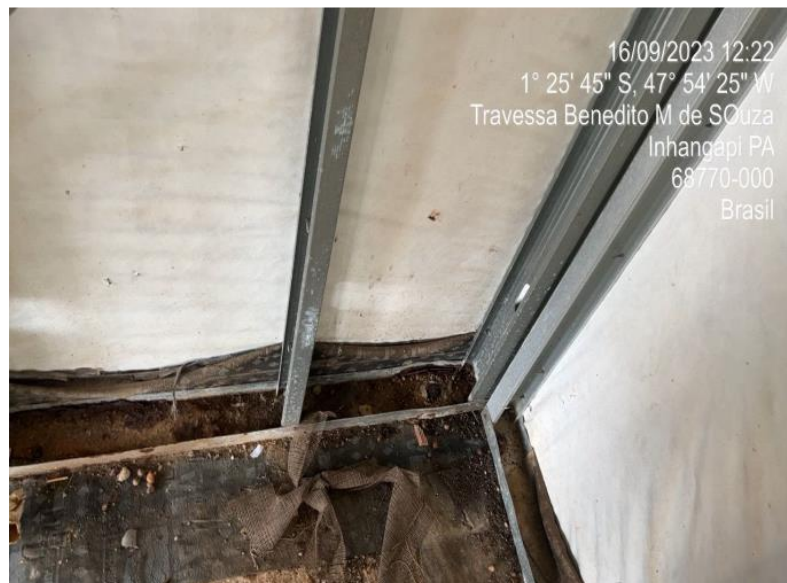
Figura 12 – perfis longitudinais em contatos com o radier em estado de corrosão.
