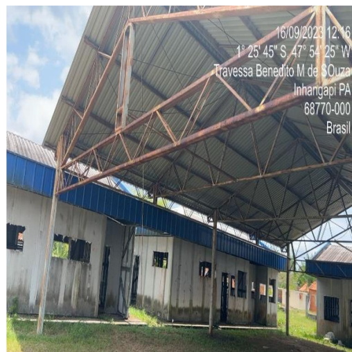
Figuras 19 e 20 – Não foram executadas as telhas translúcidas no pátio central, item este que consta como inconformidade no SIMEC.
