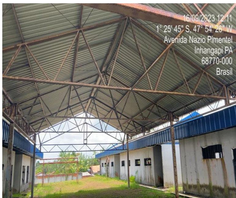
Figura 10 – vigas, pilares e tesouras estão expostos às intempéries. Fonte: elaboração própria.
