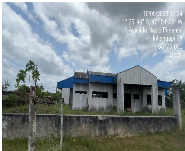
Figura 2 - Fachada frontal – fechamento externo apresentando limos e expansão das placas inferiores em diversas regiões, provocada por umidade percolante de fora para dentro. Fonte: elaboração própria
