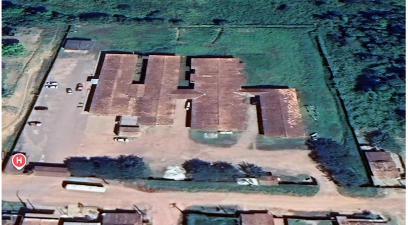
Imagem do prédio do Hospital Municipal de Tomé-Açu/PA
