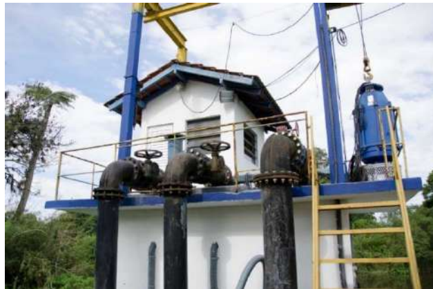
Figura 9 – Vista geral da casa de bombas
