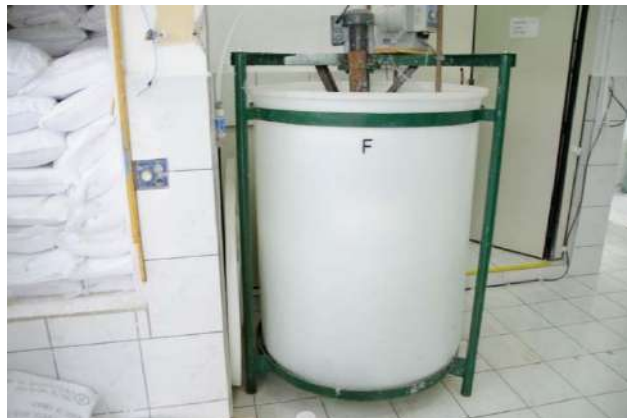
Figura 27 – Casa de química da ETA
