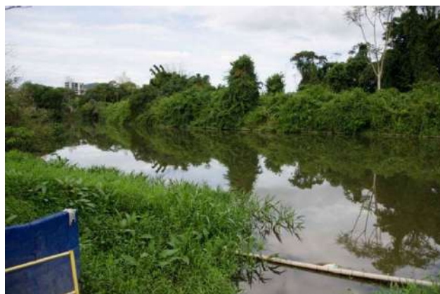
Figura 5 – Vista geral do canal de adução de água bruta
