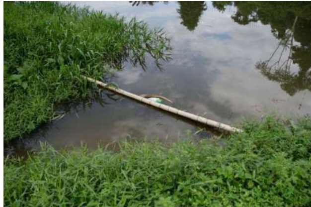
Figura 6 – Vista geral do canal de adução de água bruta
