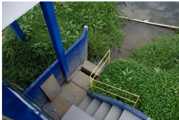
Figura 7 – Vista geral do canal de adução de água bruta
