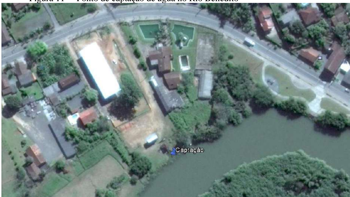
Figura 11 – Ponto de captação de água no Rio Benedito
