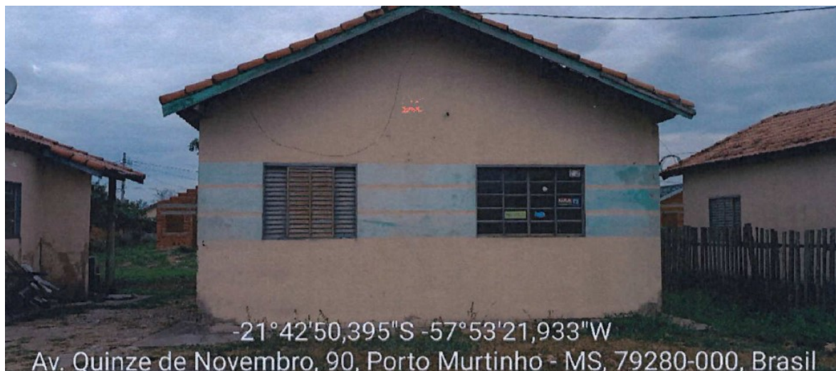
Figura 1. Unidade habitacional que necessita ser demolida e reconstruída.
