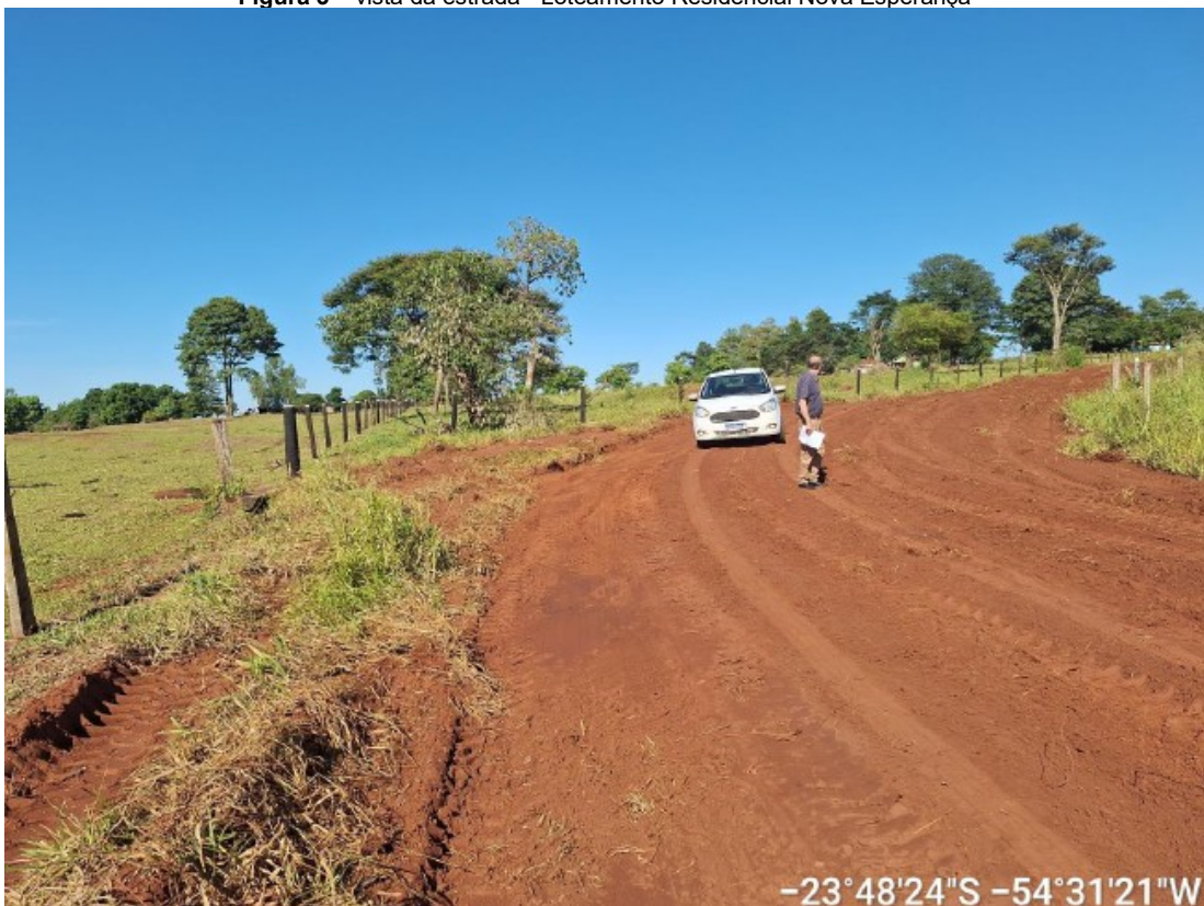
Figura 3 – vista da estrada - Loteamento Residencial Nova Esperança
