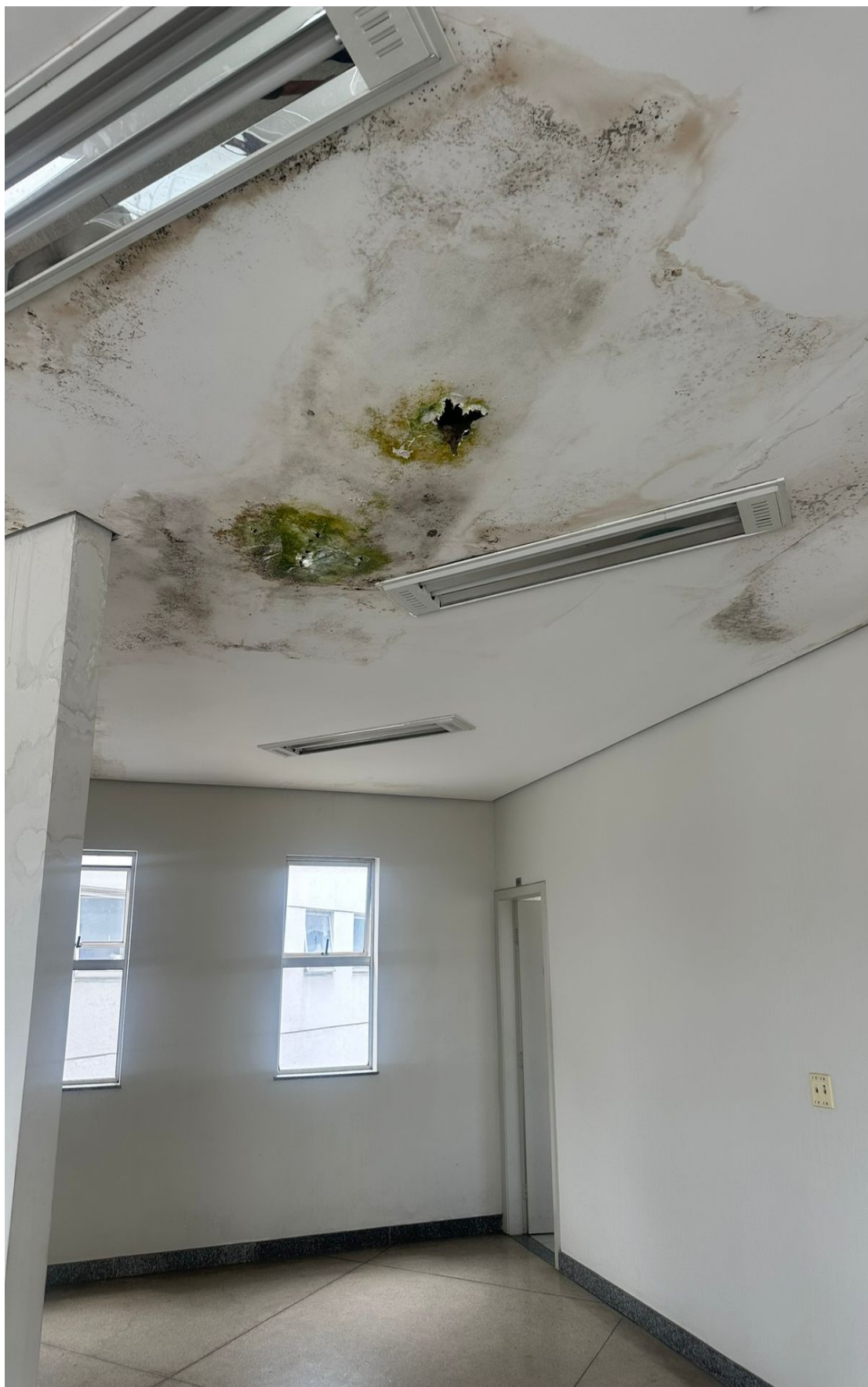
Figura 2 - Forro de gesso - Hall do 2º pavimento
