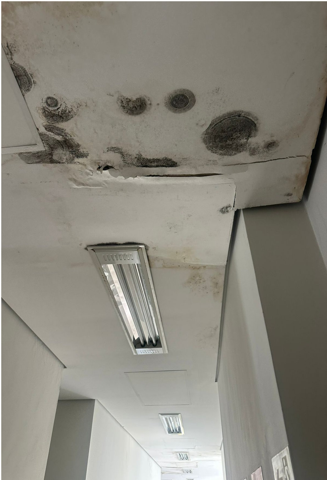
Figura 1 - Forro de gesso - Hall do 2º pavimento
