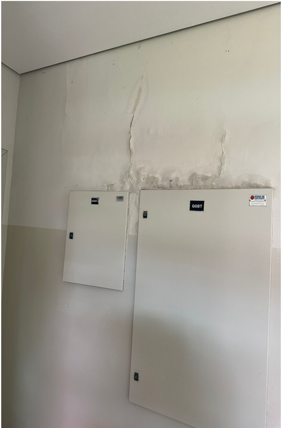
Figura 4 - Parede do hall - Pavimento térreo
