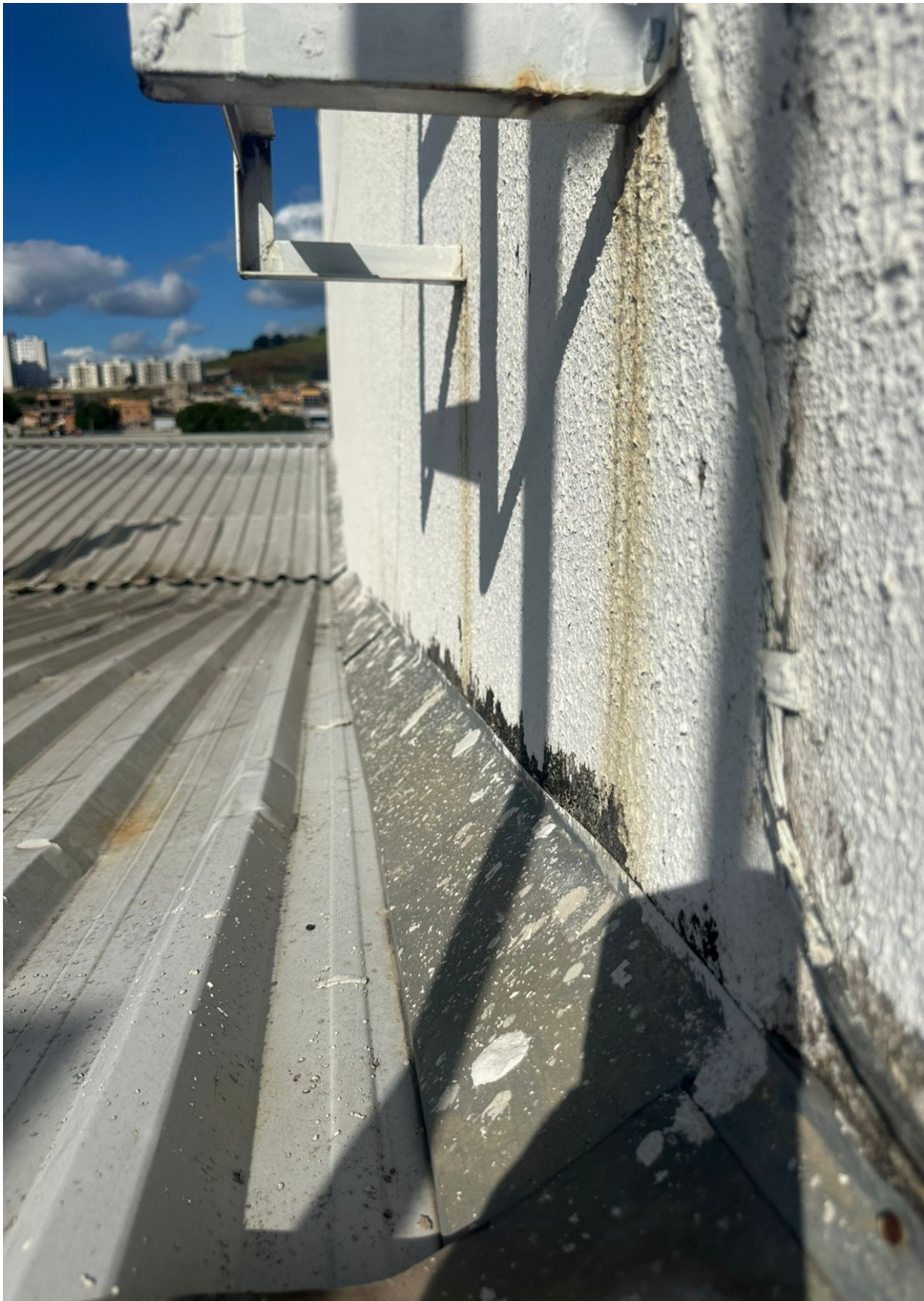
Figura 5 - Elementos da cobertura metálica
