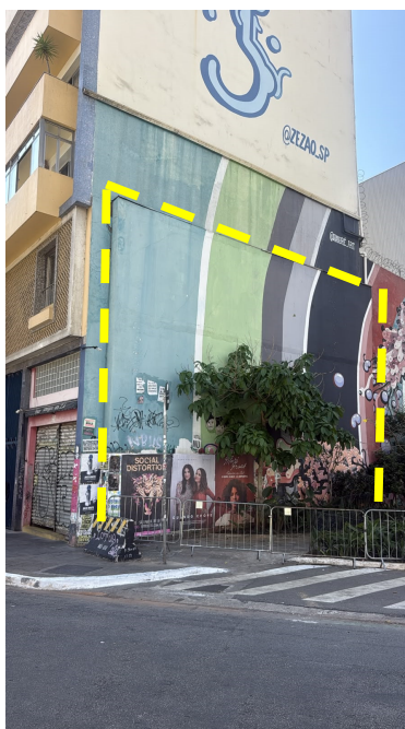
A imagem mostra o muro a ser demolido da Praça Tarcísio Meira.
