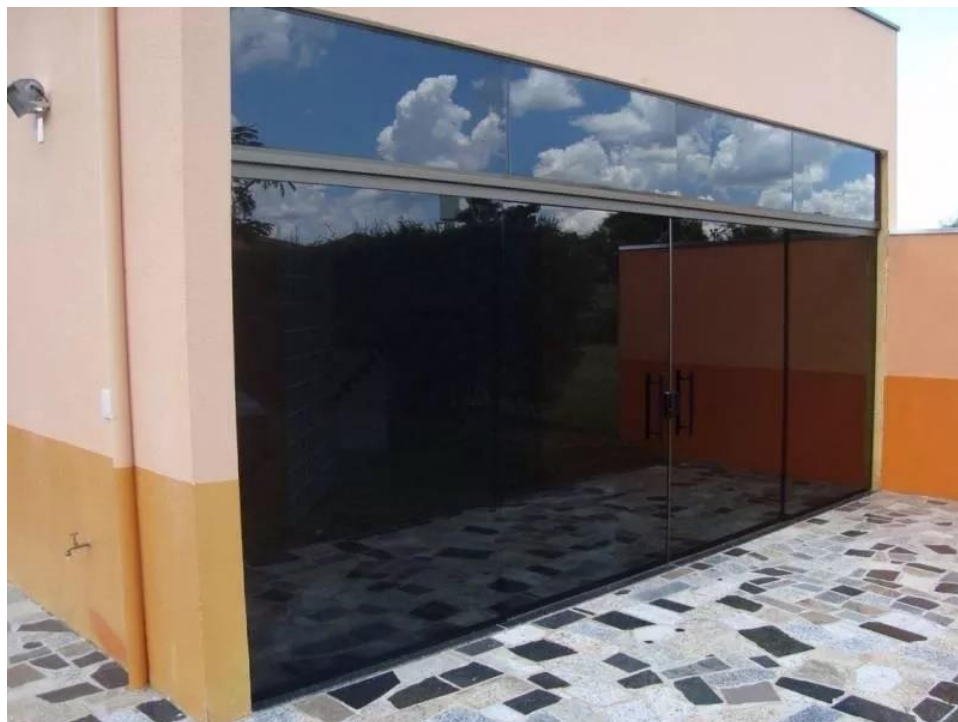
Figura – Representação ilustrativa de Porta de Correr com Bandeira Fixa Superior de Vidro Temperado Fumê 10mm
