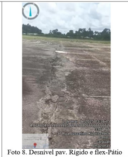
Foto 8. Desnivel pav. Rígido e flex-Pátio
