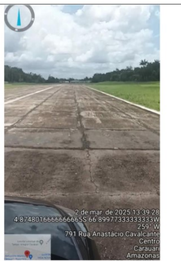
Foto 2. Pav. Rígido falta de junta - PPD
