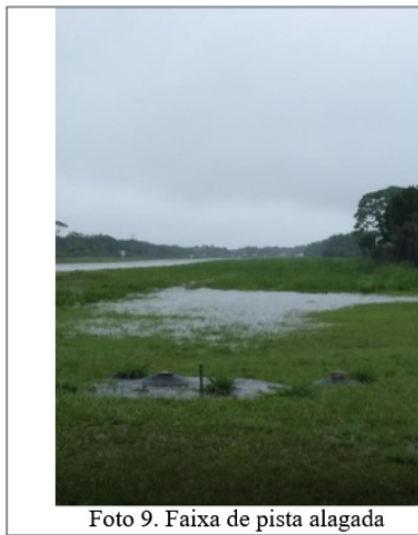
Foto 9. Faixa de pista alagada
