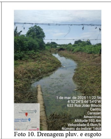
Foto 10. Drenagem pluv. e esgoto
