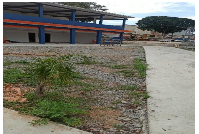
PASSEIO EM CONCRETO
