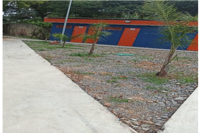
EDIFICAÇÃO A SER DEMOLIDA
