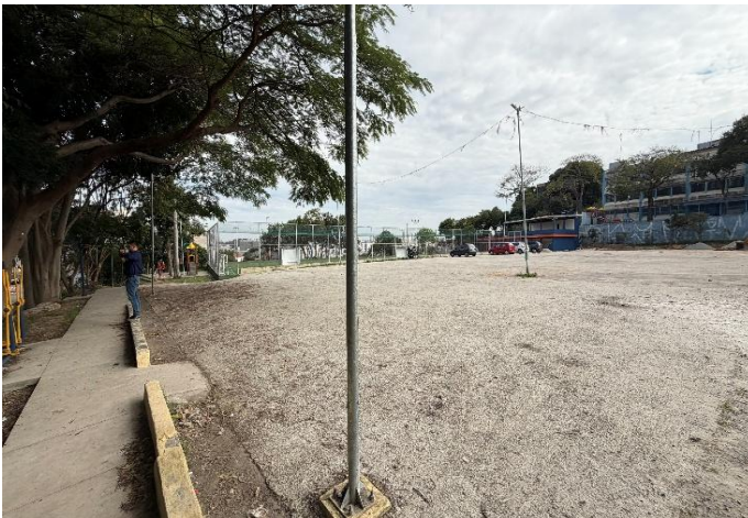
PERSPECTIVA DE PÁTIO CONCRETADO
