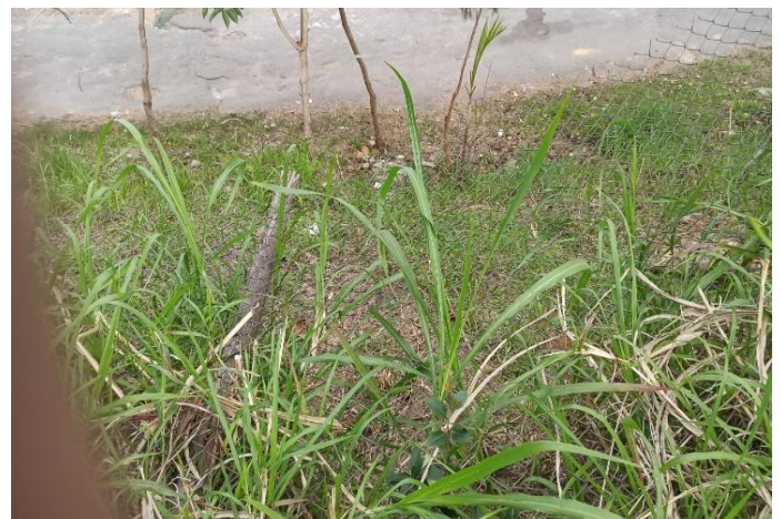
ALAMBRADO DE LIMITE DO TALUDE
