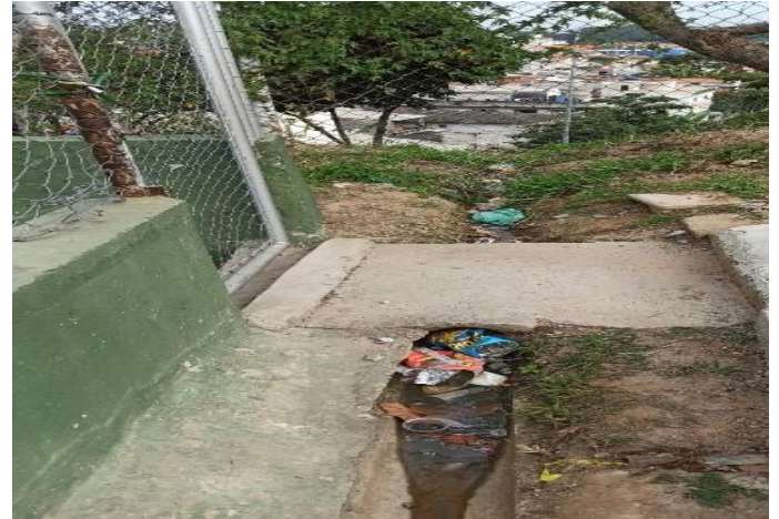
CANAleta MEIA CANA AO LADO DO CAMPO
