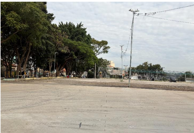
PERSPECTIVA DA ÁREA CONCRETADA
