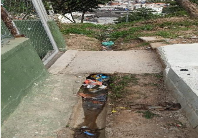
CANAleta MEIA CANA AO LADO DO CAMPO
