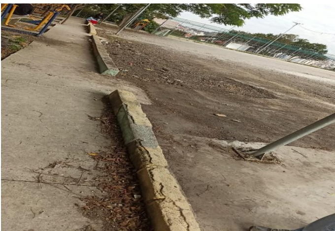
VESTIÁRIOS A SEREM DEMOLIDOS
