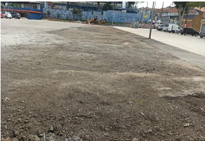
SANITÁRIOS A SEREM DEMOLIDOS
