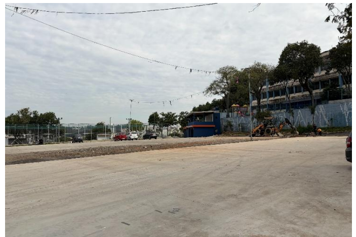
PERSPECTIVA DA ÁREA CONCRETADA
