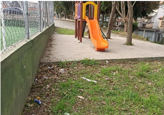
BASE DE PLAYGROUND EM CONCRETO
