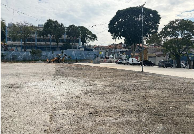
SOLO A SER CONCRETADO
