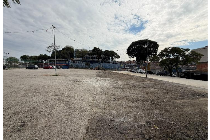
DELIMITAÇÃO DE AREA CONCRETADA
