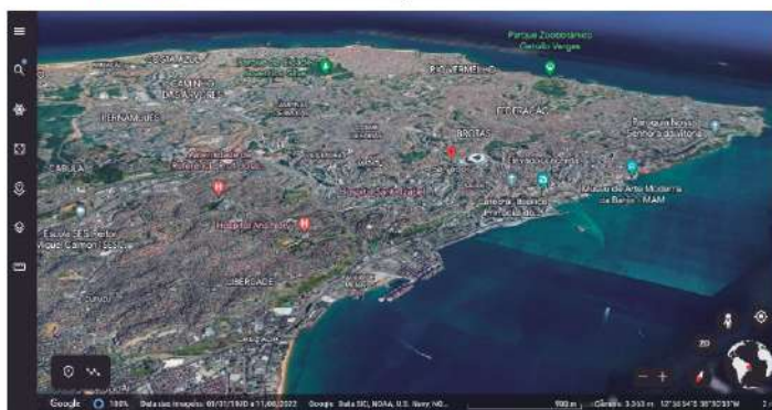
FIGURA 5 Vista aérea do município de Salvador
