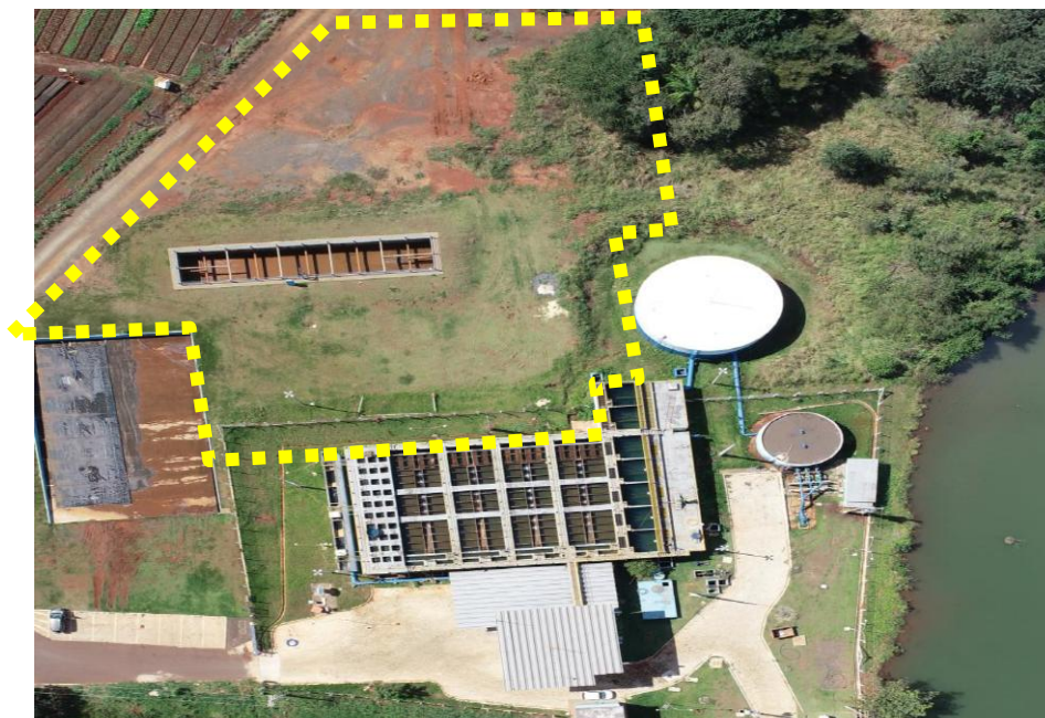
Figura 2 - Vista aérea da ETA existente.
