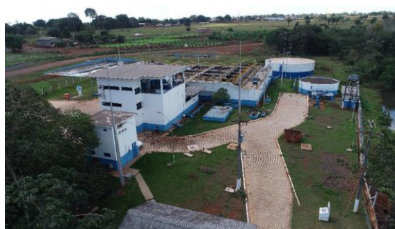
Figura 11 - Vista aérea das estruturas existentes.
