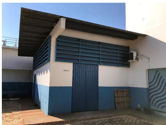
Figura 04 - Vista da entrada do depósito de produtos químicos. Estrutura em bom estado de conservação.
