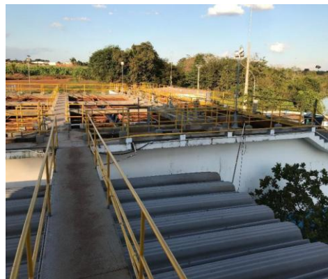
Figura 07 - Passarela de transição entre a ETA e Casa de Química.
