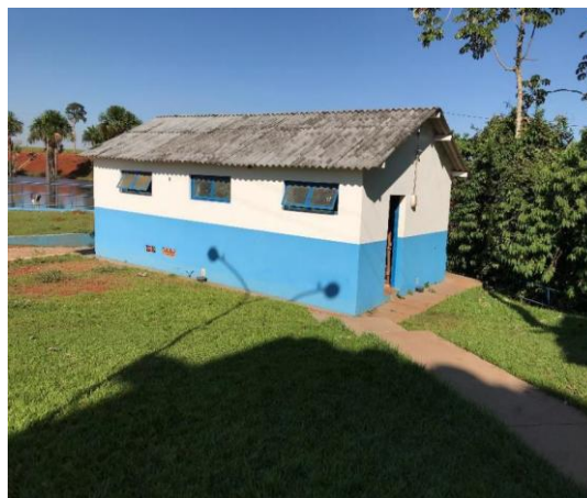
Figura 1- Vista da Elevatória de Água Bruta
