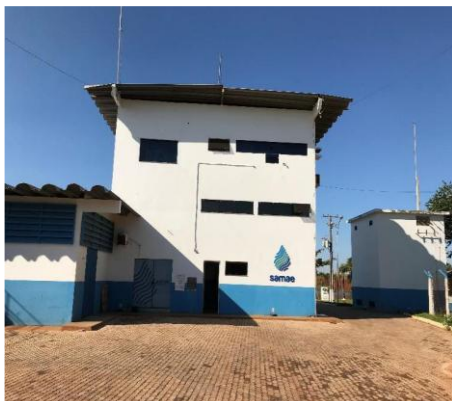
Figura 06 - Vista da fachada de entrada da casa de química.
