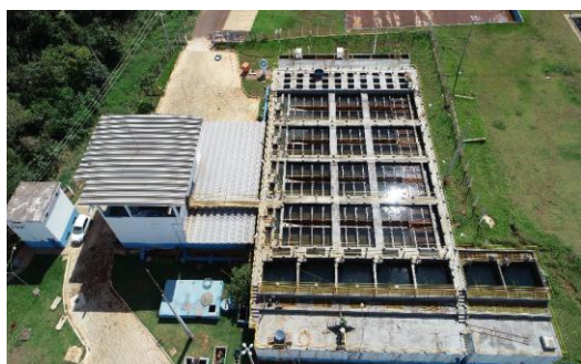
Figura 10- Vista aérea da ETA, com todas as unidades de tratamento.
