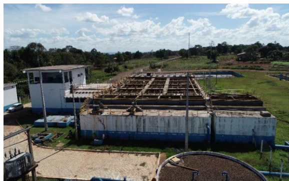
Figura 09 - Fachada lateral de toda a estrutura da ETA existente. Em primeiro plano, vista do tanque de contato existente.
