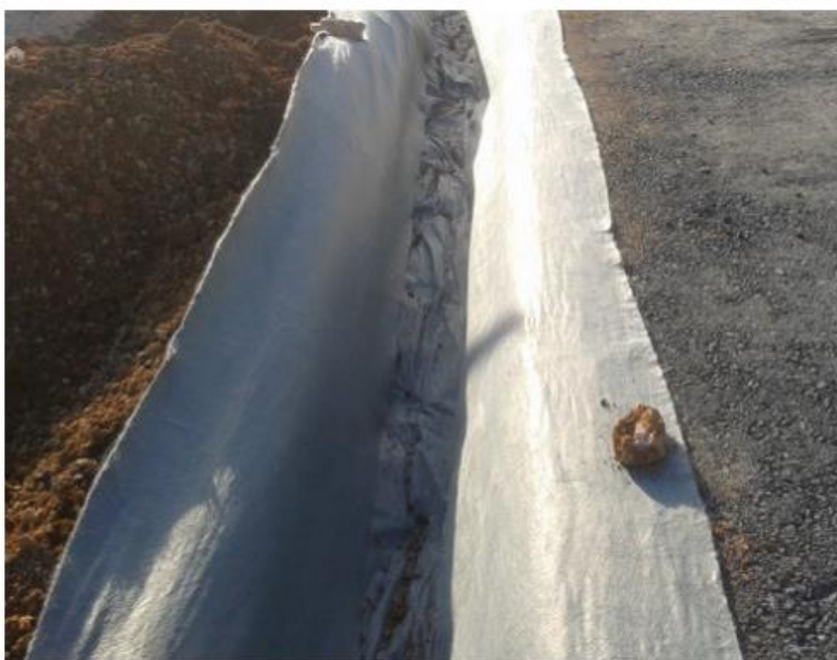
Figura 5 -Colocação da manta geotêxtil.
