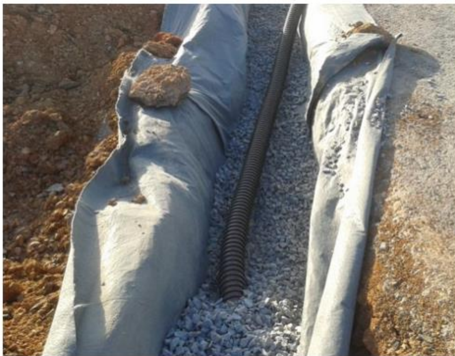
Figura 6 -Colocação da brita sobre a manta geotêxtil.
