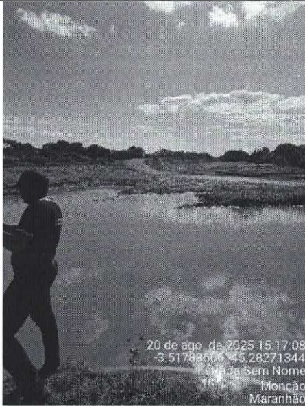
Vista do ponto de intervenção com aterro provisório, lado esquerdo - avanço do rio formando uma lagoa.
