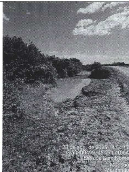
Vista do trecho 03- local da intervenção na via. Lado esquerdo área alagável (vazante).
