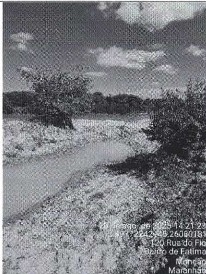
Vista do aterro provisório feito na via para passagens de veículos e pedestres.
