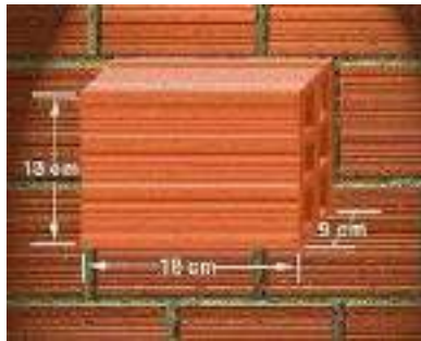
Figura 02. Alvenaria dobrada com blocos cerâmicos 06 furos
