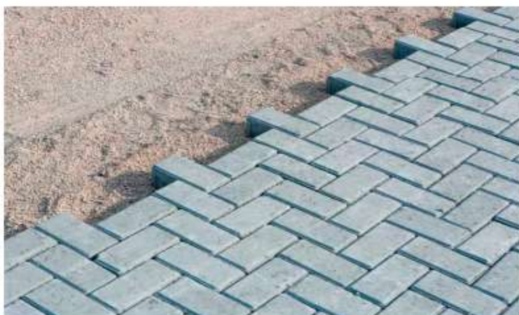
Imagem 04 – Piso de concreto intertravado
