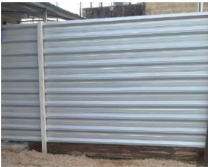
Imagem 03 – Tapume com telha metálica.
