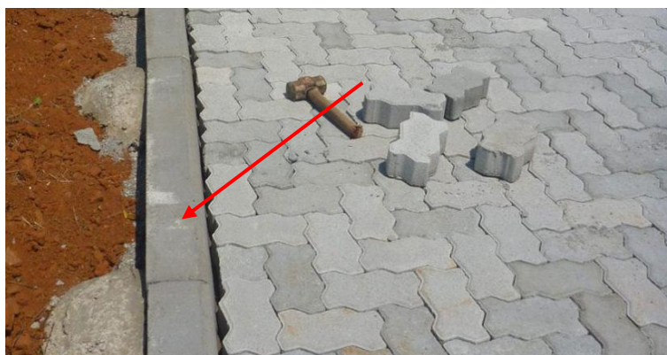
Figura 6: Viga de Contenção (contenção Fim)
