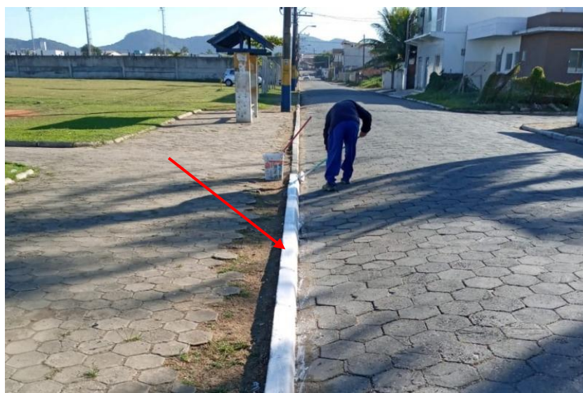
Figura 4: Pintura de Meio-Fio
