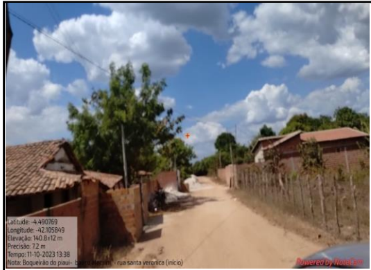
Foto: Início de trecho da rua RUA SANTA VERONICA
