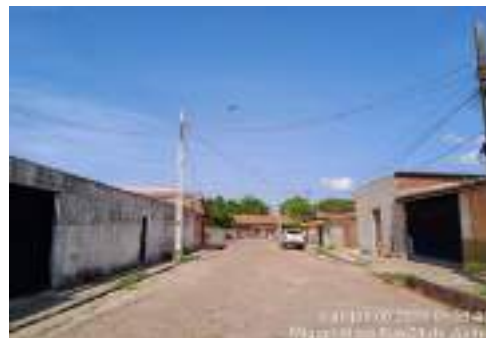
FOTO N° 10: RUA 01 DE JUNHO
