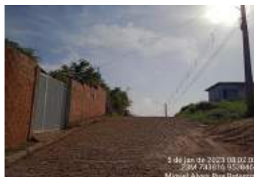
FOTO N° 4: RUA RETENTOR TRECHO 02
