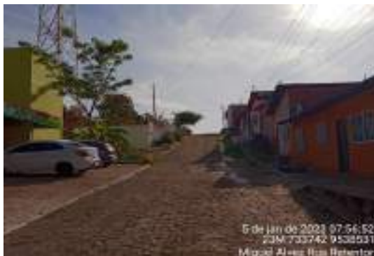
FOTO Nº 19: RUA RETENTOR TRECHO 03
