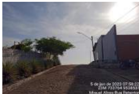
FOTO Nº 20: RUA RETENTOR TRECHO 03
