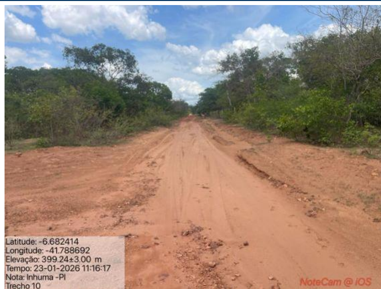
Foto 87: Situação do trecho estrada que sofrerá intervenção
