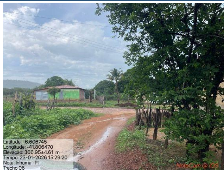
Foto 50: Situação do trecho estrada que sofrerá intervenção
