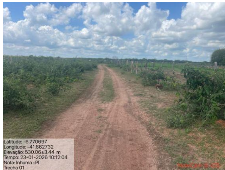
Foto 17: Situação do trecho estrada que sofrerá intervenção
