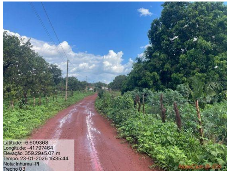
Foto 31: Situação do trecho estrada que sofrerá intervenção
