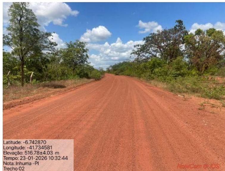
Foto 21: Situação do trecho estrada que sofrerá intervenção
