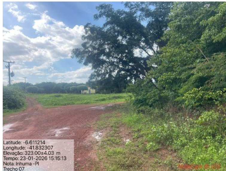
Foto 60: Situação do trecho estrada que sofrerá intervenção
