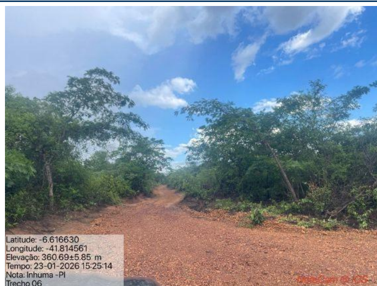
Foto 55: Situação do trecho estrada que sofrerá intervenção
