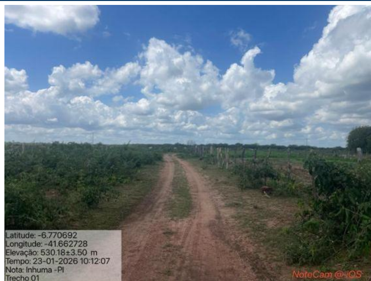
Foto 18: Situação do trecho estrada que sofrerá intervenção
