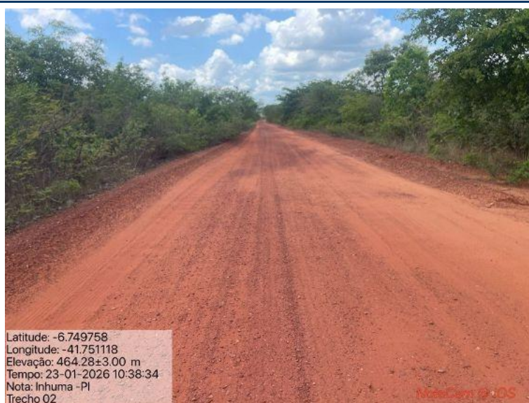
Foto 24: Situação do trecho estrada que sofrerá intervenção
