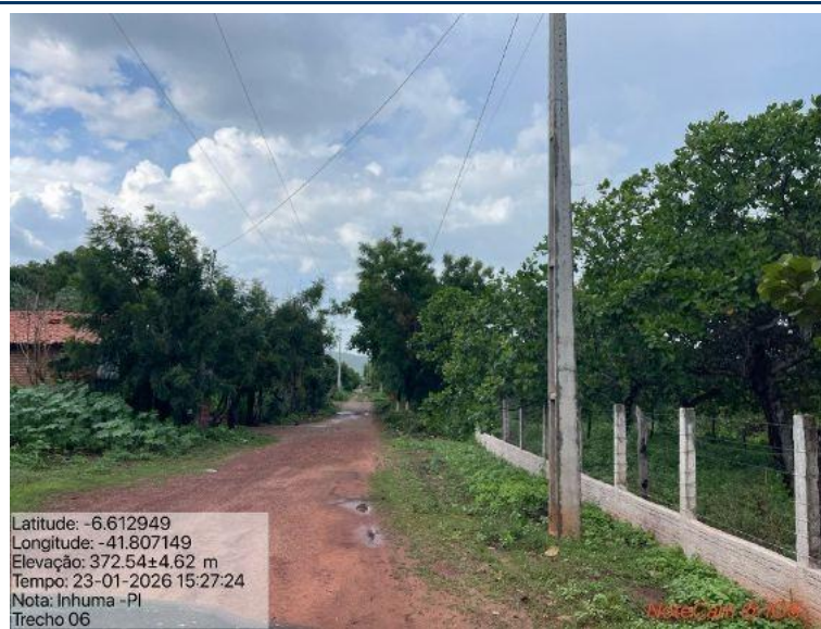
Foto 51: Situação do trecho estrada que sofrerá intervenção
