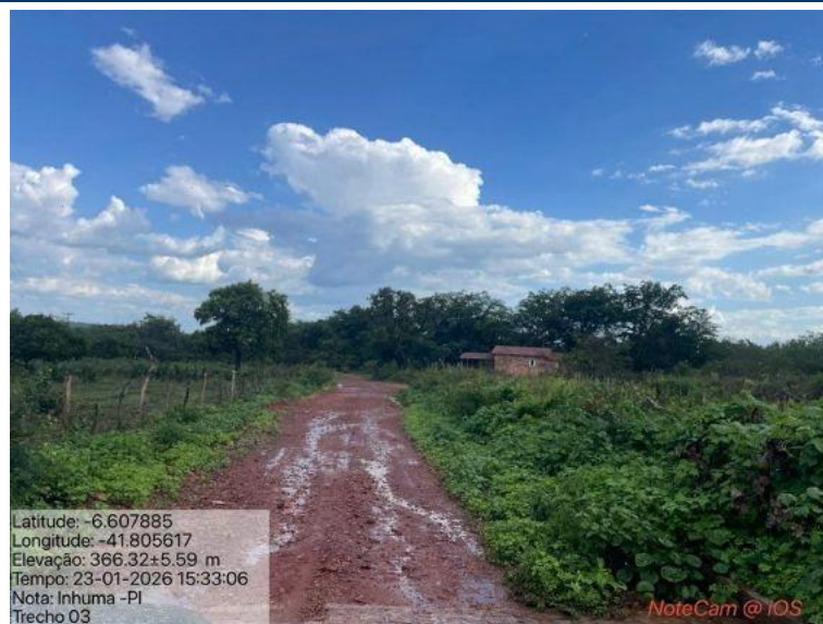
Foto 33: Situação do trecho estrada que sofrerá intervenção
