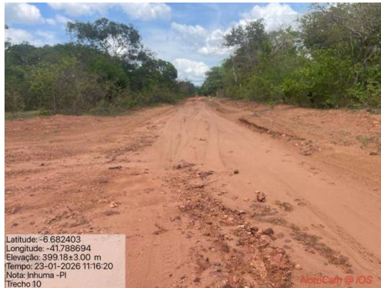
Foto 68: Situação do trecho estrada que sofrerá intervenção
