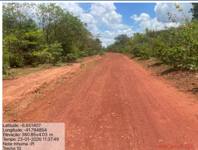
Foto 79: Situação do trecho estrada que sofrerá intervenção
