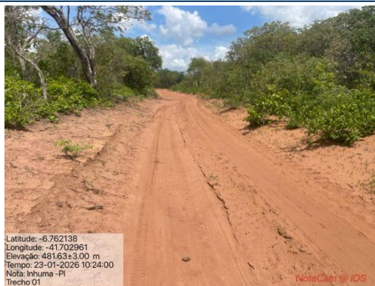
Foto 07: Situação do trecho estrada que sofrerá intervenção
