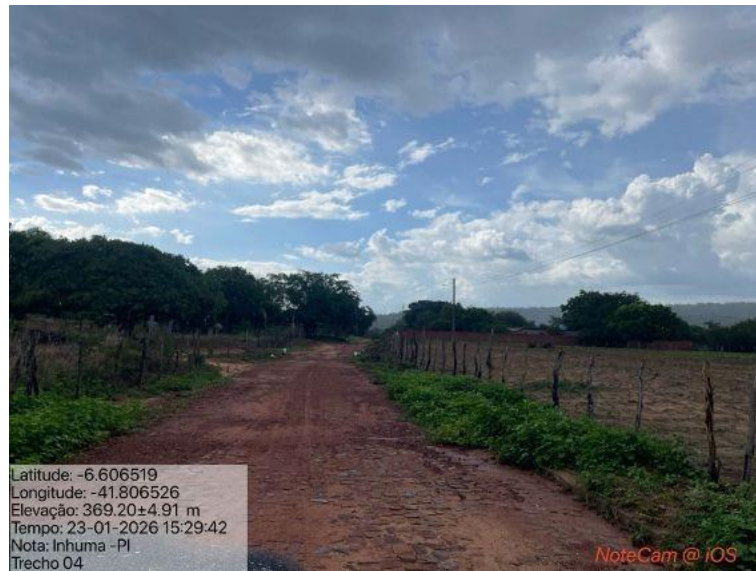
Foto 37: Situação do trecho estrada que sofrerá intervenção
