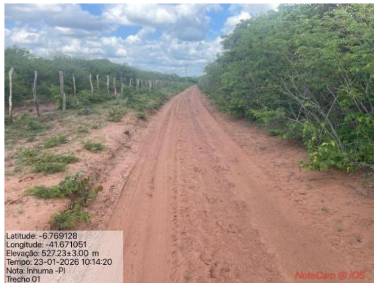
Foto 19: Situação do trecho estrada que sofrerá intervenção
