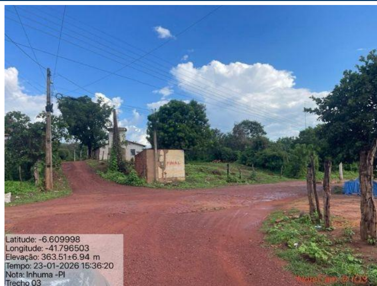
Foto 32: Situação do trecho estrada que sofrerá intervenção
