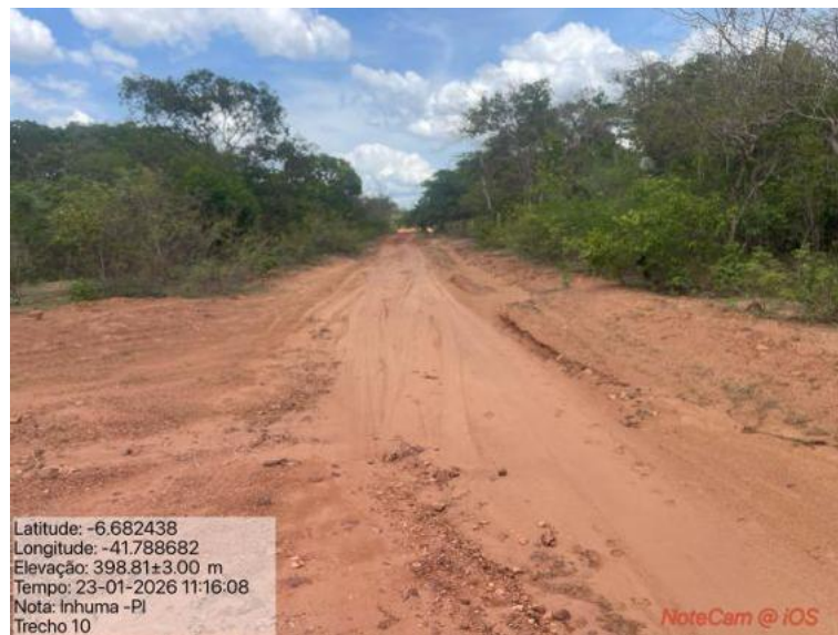
Foto 86: Situação do trecho estrada que sofrerá intervenção
