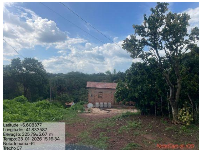
Foto 56: Situação do trecho estrada que sofrerá intervenção
