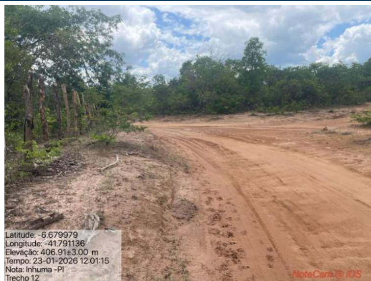
Foto 95: Situação do trecho estrada que sofrerá intervenção
