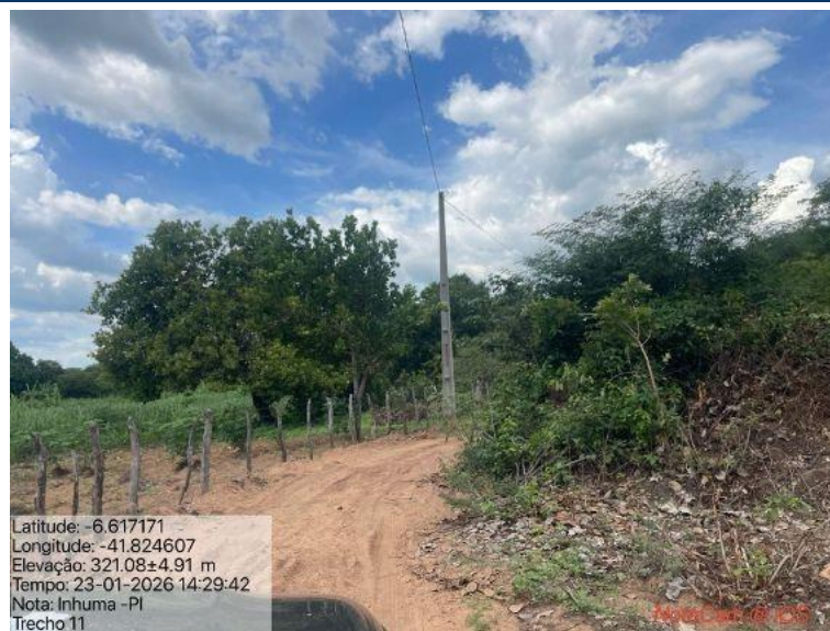
Foto 92: Situação do trecho estrada que sofrerá intervenção
