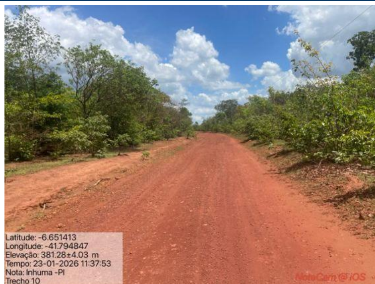
Foto 83: Situação do trecho estrada que sofrerá intervenção
