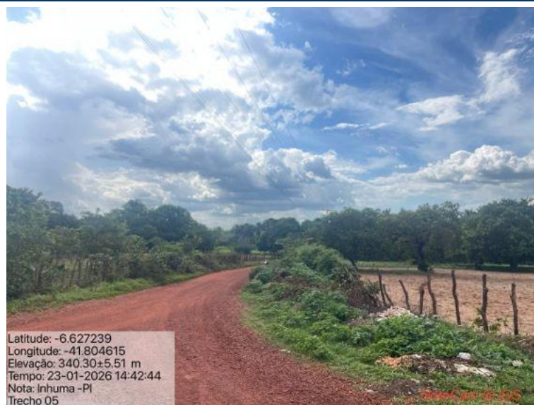
Foto 49: Situação do trecho estrada que sofrerá intervenção
