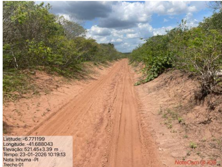
Foto 03: Situação do trecho estrada que sofrerá intervenção
