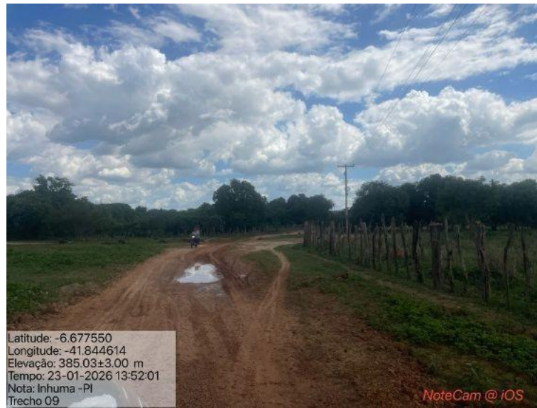
Foto 66: Situação do trecho estrada que sofrerá intervenção
