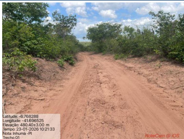
Foto 06: Situação do trecho estrada que sofrerá intervenção
