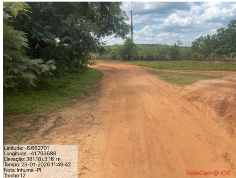
Foto 100: Situação do trecho estrada que sofrerá intervenção
