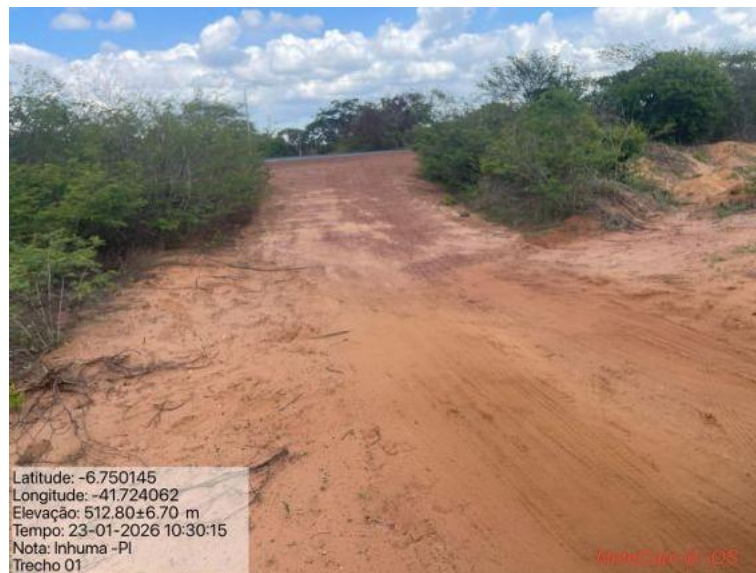
Foto 15: Situação do trecho estrada que sofrerá intervenção
