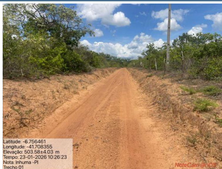
Foto 10: Situação do trecho estrada que sofrerá intervenção
