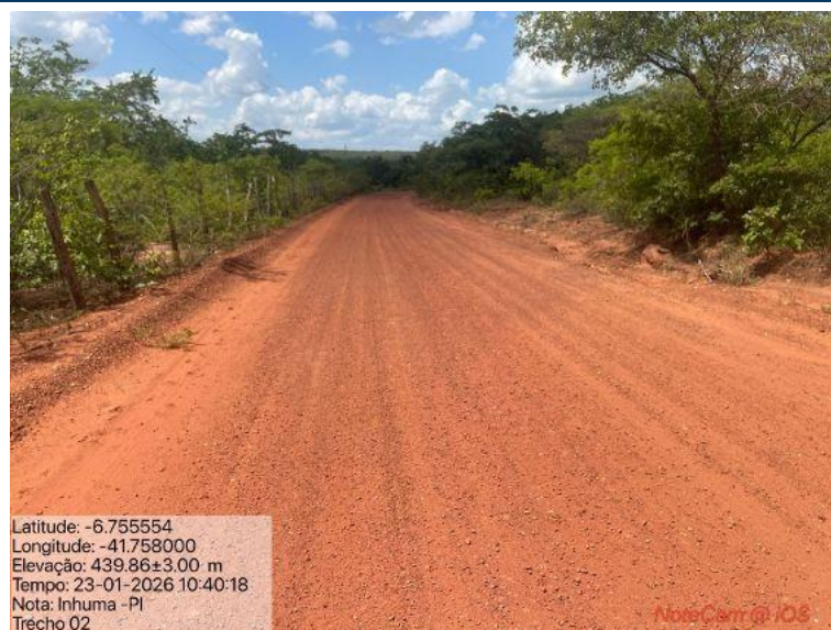
Foto 26: Situação do trecho estrada que sofrerá intervenção
