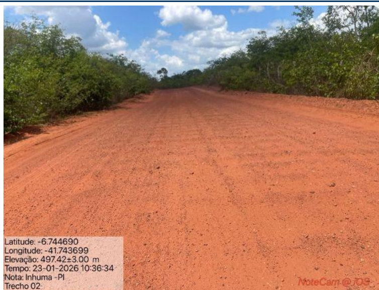
Foto 23: Situação do trecho estrada que sofrerá intervenção
