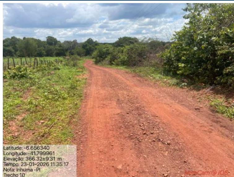
Foto 75: Situação do trecho estrada que sofrerá intervenção
