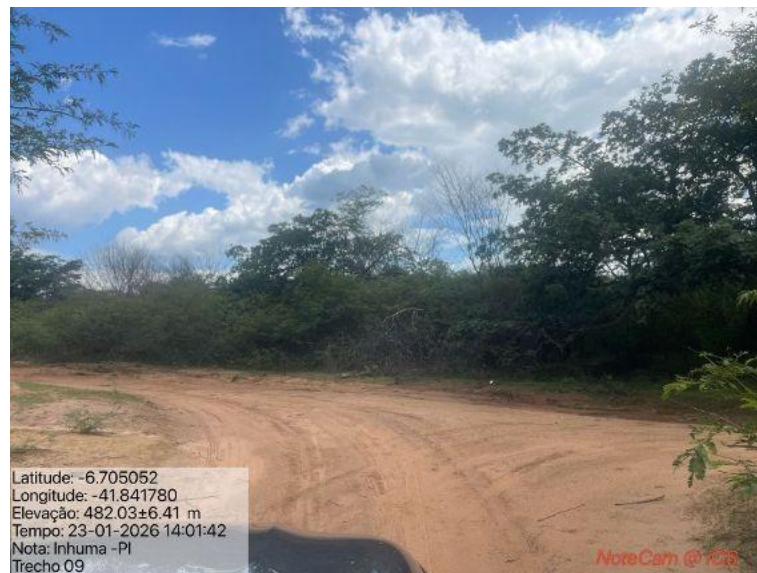
Foto 62: Situação do trecho estrada que sofrerá intervenção
