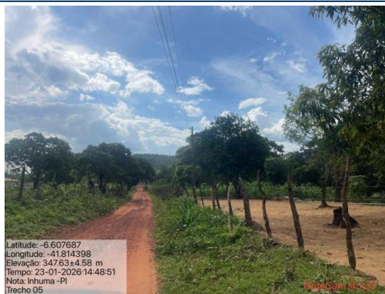
Foto 46: Situação do trecho estrada que sofrerá intervenção
