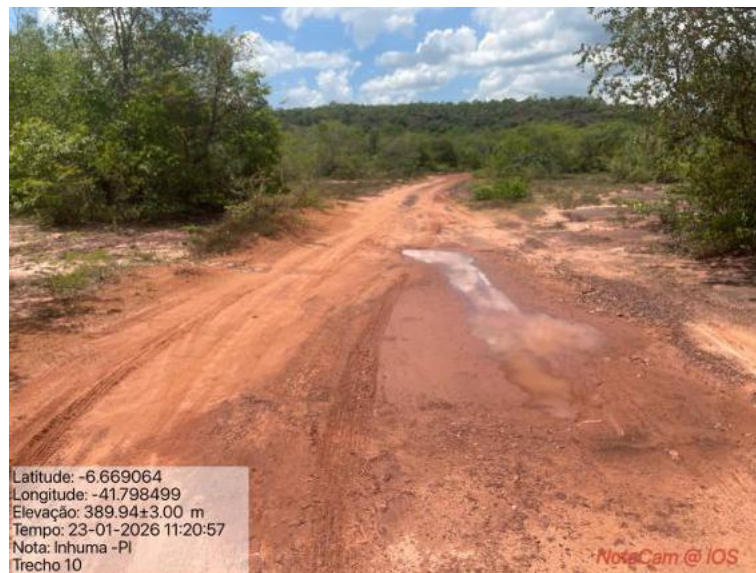
Foto 74: Situação do trecho estrada que sofrerá intervenção
