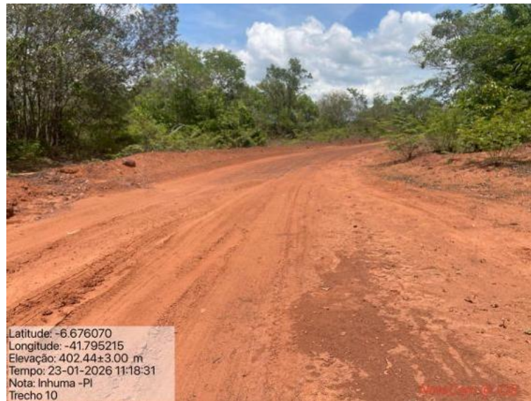
Foto 70: Situação do trecho estrada que sofrerá intervenção
