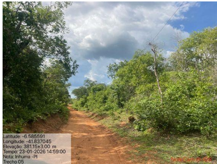
Foto 42: Situação do trecho estrada que sofrerá intervenção
