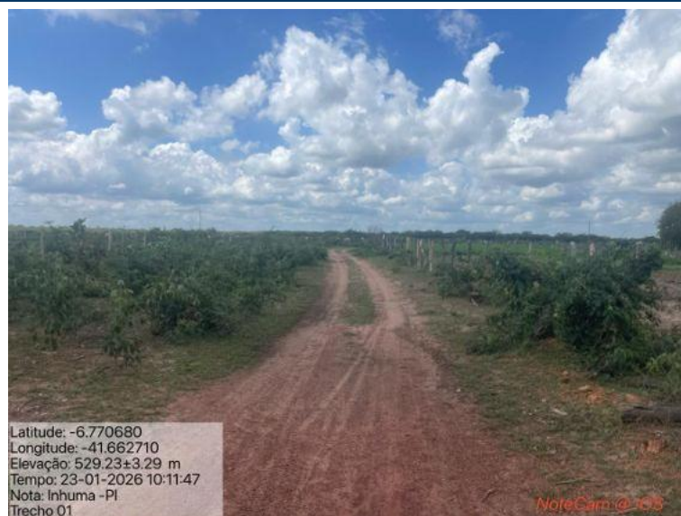
Foto 16: Situação do trecho estrada que sofrerá intervenção
