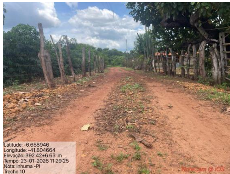
Foto 76: Situação do trecho estrada que sofrerá intervenção
