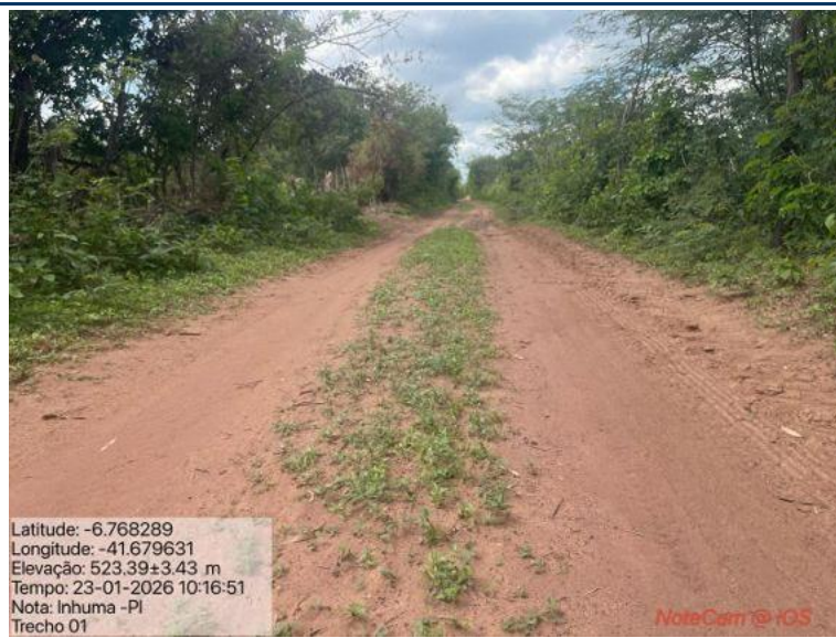
Foto 01: Situação do trecho estrada que sofrerá intervenção
