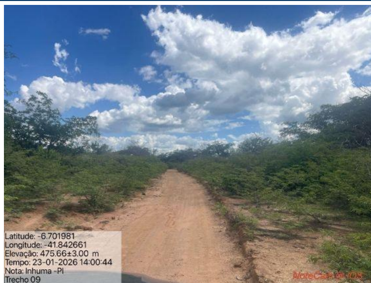
Foto 67: Situação do trecho estrada que sofrerá intervenção
