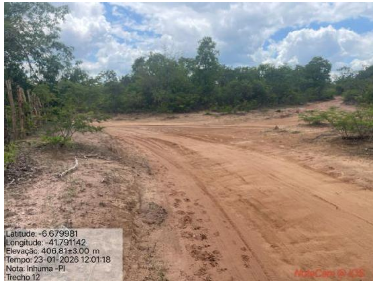
Foto 94: Situação do trecho estrada que sofrerá intervenção
