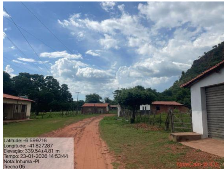
Foto 44: Situação do trecho estrada que sofrerá intervenção
