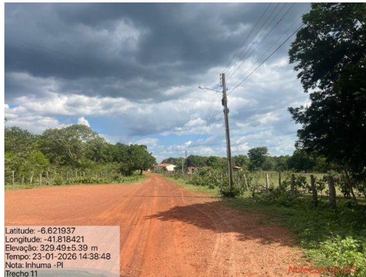
Foto 90: Situação do trecho estrada que sofrerá intervenção
