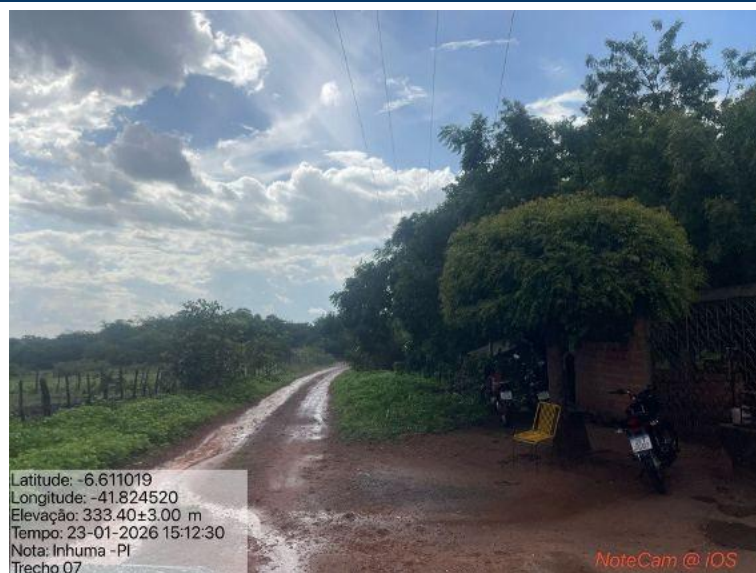
Foto 61: Situação do trecho estrada que sofrerá intervenção
