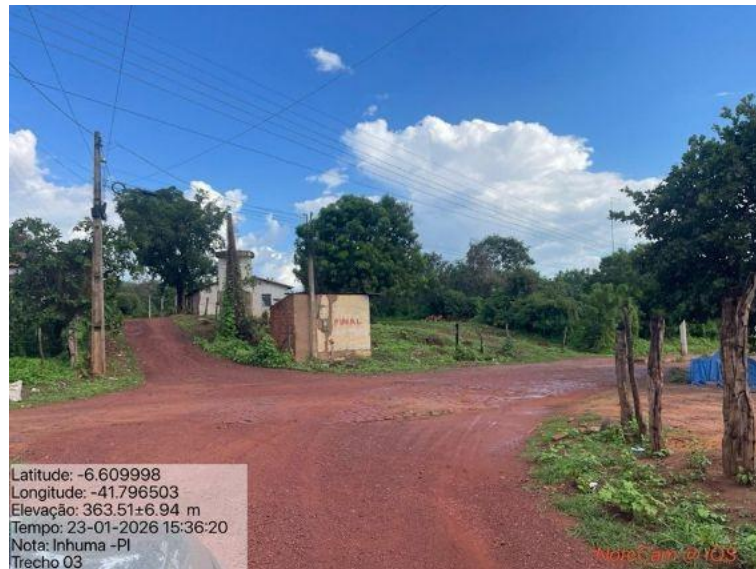
Foto 35: Situação do trecho estrada que sofrerá intervenção
