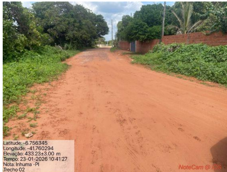
Foto 29: Situação do trecho estrada que sofrerá intervenção
