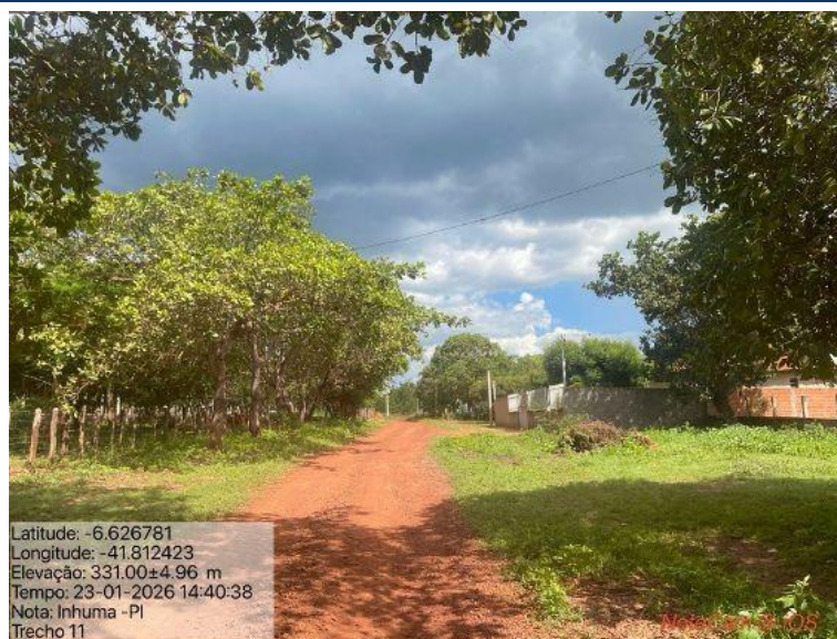
Foto 93: Situação do trecho estrada que sofrerá intervenção
