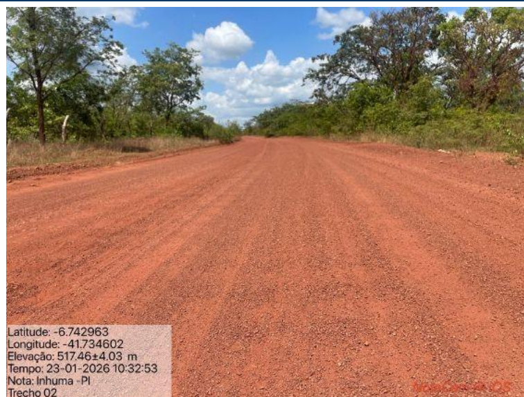
Foto 22: Situação do trecho estrada que sofrerá intervenção
