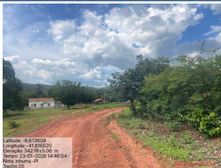
Foto 47: Situação do trecho estrada que sofrerá intervenção
