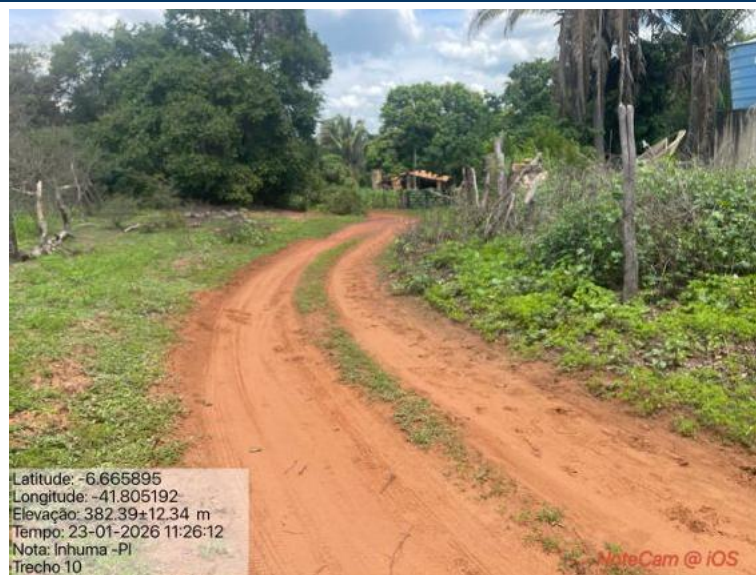
Foto 78: Situação do trecho estrada que sofrerá intervenção
