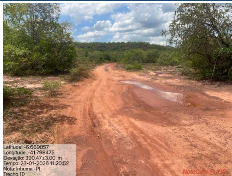
Foto 69: Situação do trecho estrada que sofrerá intervenção
