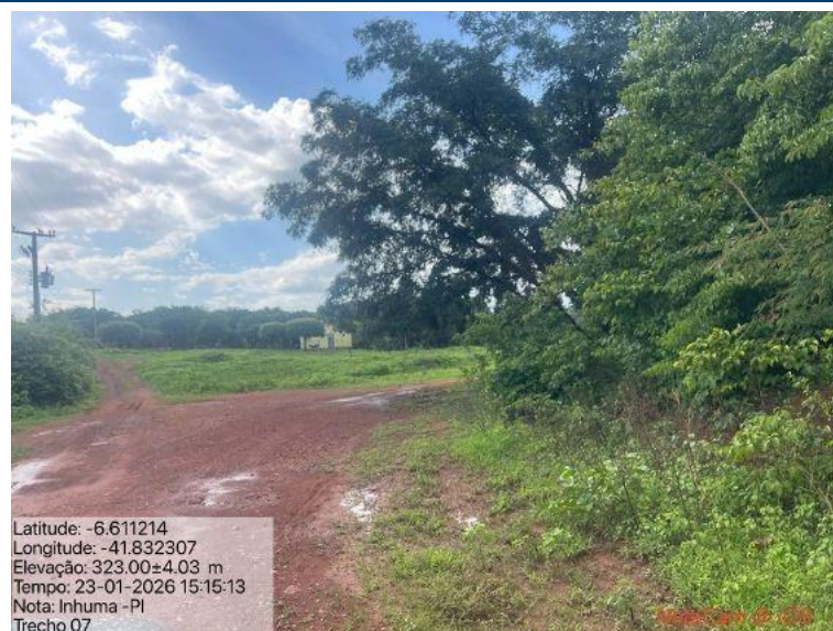
Foto 57: Situação do trecho estrada que sofrerá intervenção
