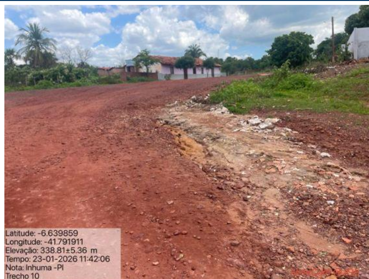
Foto 85: Situação do trecho estrada que sofrerá intervenção
