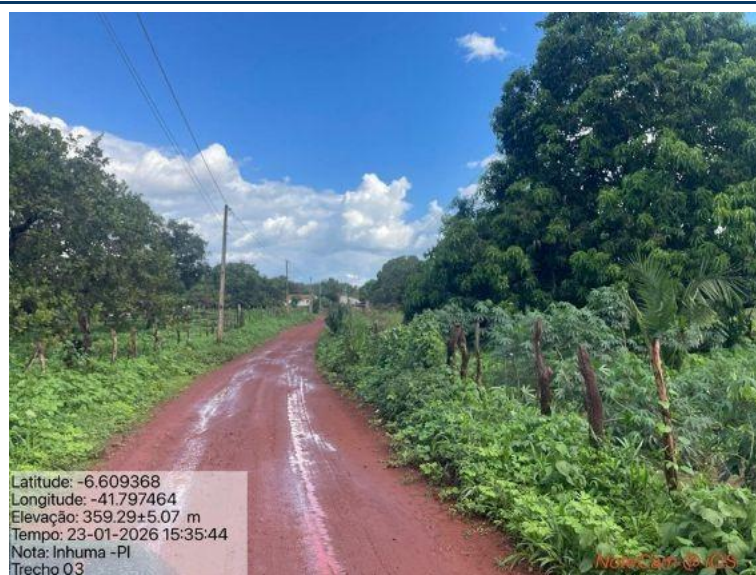
Foto 34: Situação do trecho estrada que sofrerá intervenção
