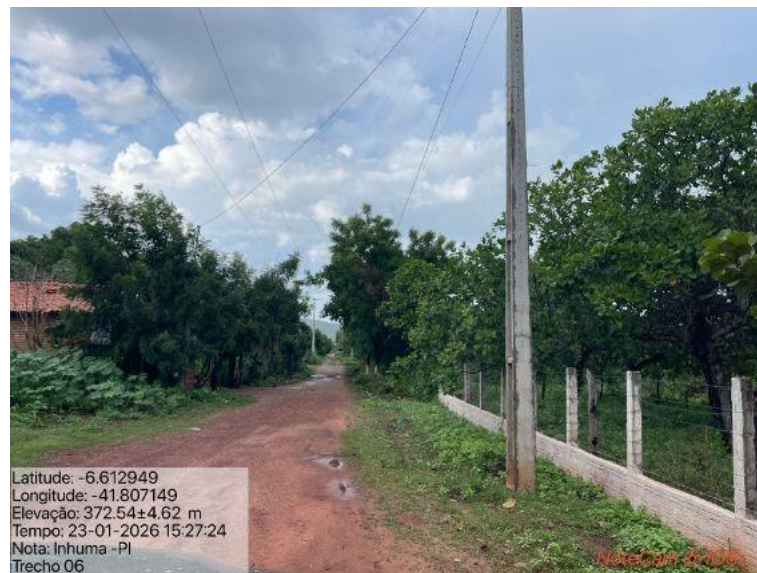
Foto 54: Situação do trecho estrada que sofrerá intervenção
