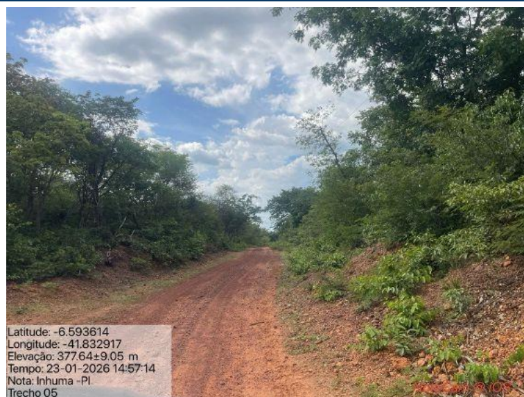
Foto 43: Situação do trecho estrada que sofrerá intervenção
