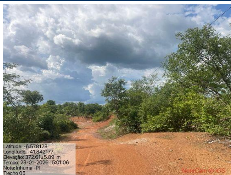
Foto 41: Situação do trecho estrada que sofrerá intervenção
