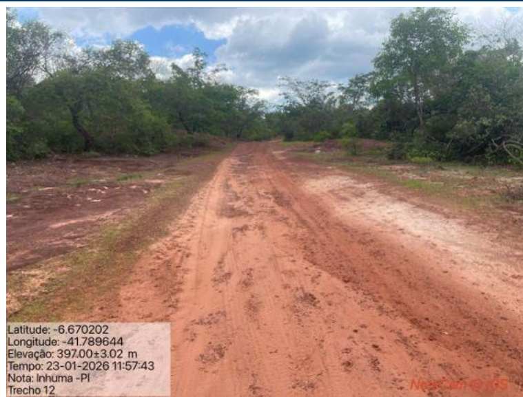
Foto 99: Situação do trecho estrada que sofrerá intervenção
