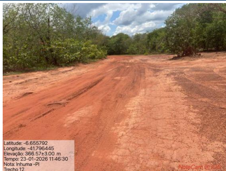
Foto 101: Situação do trecho estrada que sofrerá intervenção
