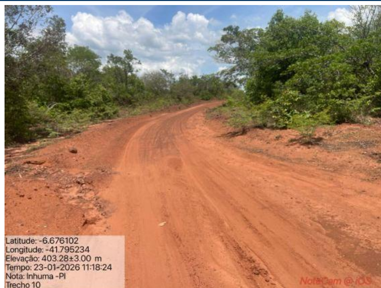
Foto 71: Situação do trecho estrada que sofrerá intervenção
