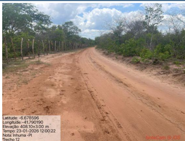
Foto 97: Situação do trecho estrada que sofrerá intervenção
