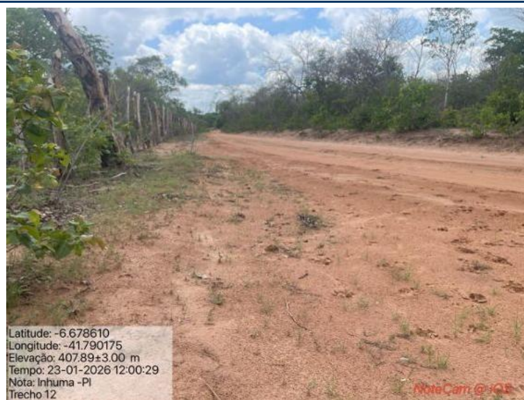
Foto 96: Situação do trecho estrada que sofrerá intervenção
