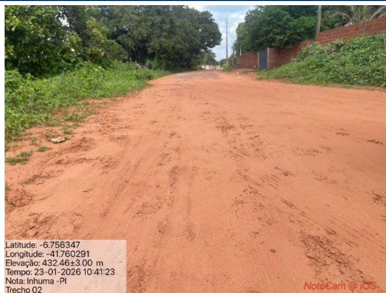
Foto 28: Situação do trecho estrada que sofrerá intervenção
