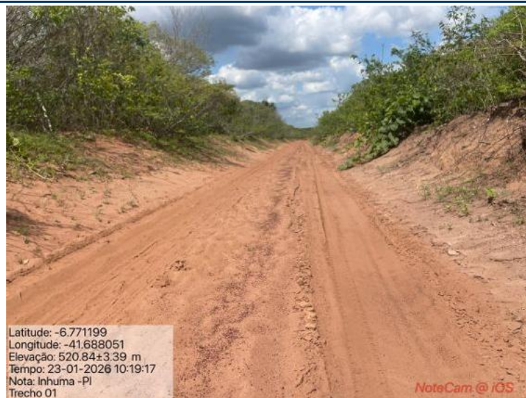
Foto 04: Situação do trecho estrada que sofrerá intervenção
