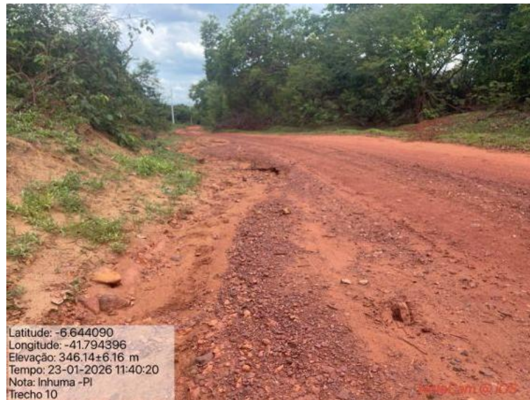
Foto 82: Situação do trecho estrada que sofrerá intervenção
