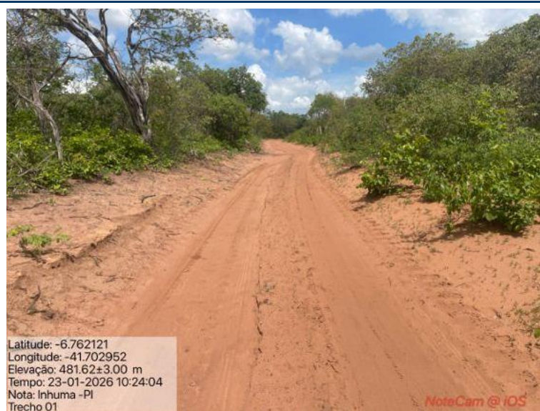
Foto 08: Situação do trecho estrada que sofrerá intervenção
