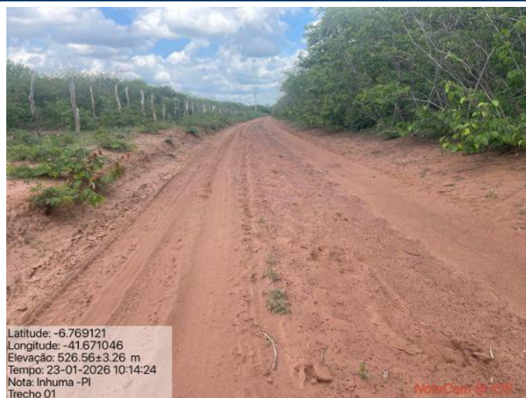
Foto 20: Situação do trecho estrada que sofrerá intervenção
