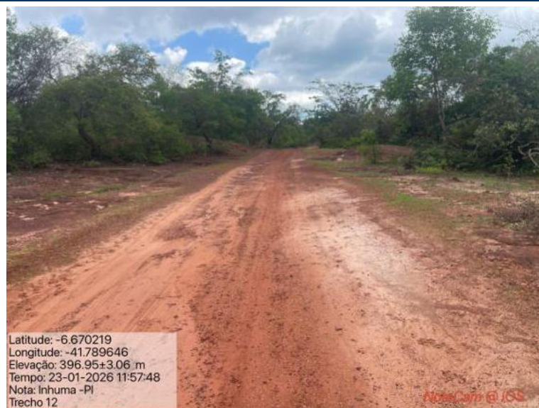
Foto 98: Situação do trecho estrada que sofrerá intervenção
