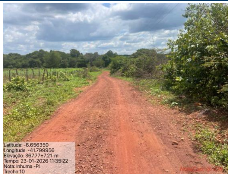
Foto 80: Situação do trecho estrada que sofrerá intervenção
