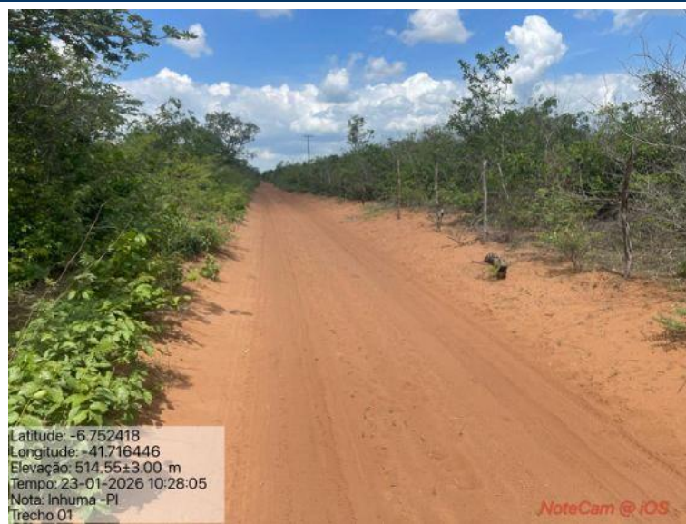
Foto 12: Situação do trecho estrada que sofrerá intervenção
