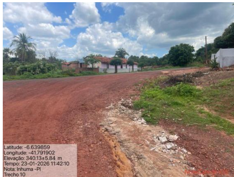
Foto 84: Situação do trecho estrada que sofrerá intervenção
