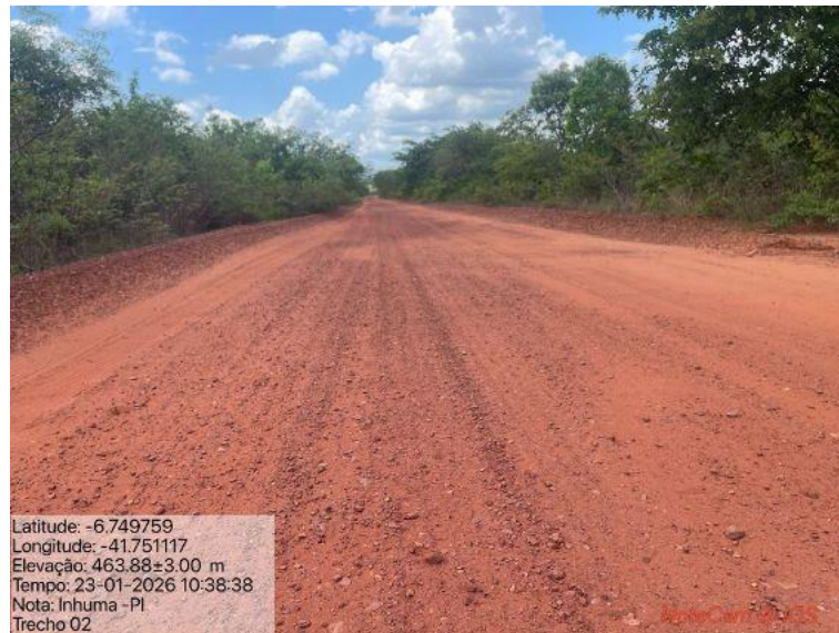
Foto 25: Situação do trecho estrada que sofrerá intervenção
