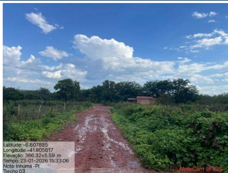
Foto 30: Situação do trecho estrada que sofrerá intervenção
