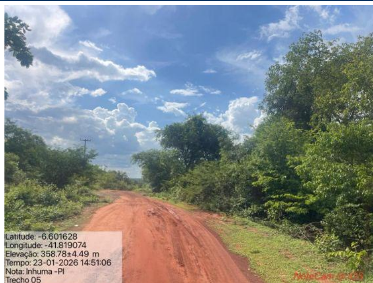
Foto 45: Situação do trecho estrada que sofrerá intervenção
