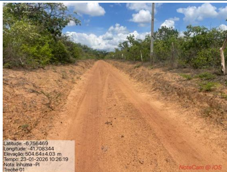
Foto 09: Situação do trecho estrada que sofrerá intervenção
