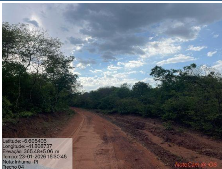
Foto 40: Situação do trecho estrada que sofrerá intervenção
