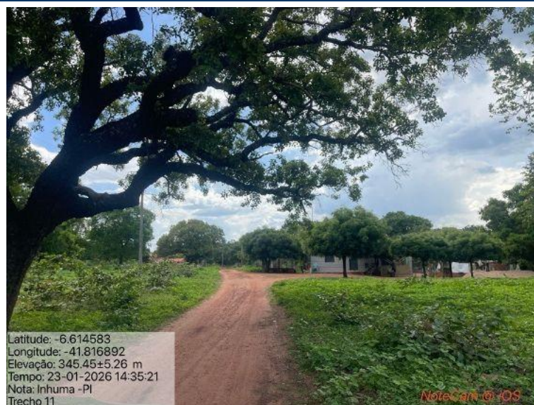
Foto 91: Situação do trecho estrada que sofrerá intervenção
