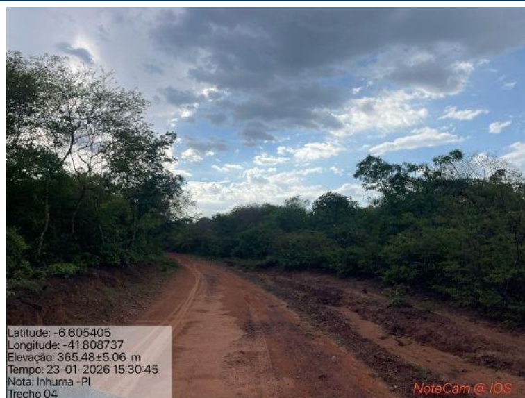
Foto 38: Situação do trecho estrada que sofrerá intervenção
