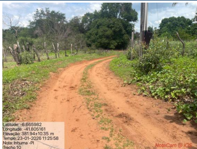
Foto 73: Situação do trecho estrada que sofrerá intervenção
