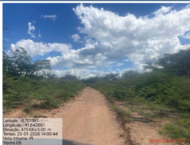
Foto 63: Situação do trecho estrada que sofrerá intervenção
