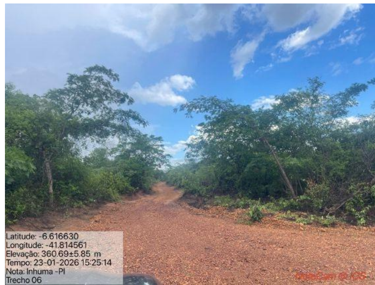
Foto 52: Situação do trecho estrada que sofrerá intervenção
