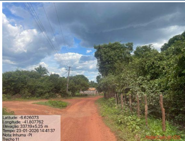
Foto 88: Situação do trecho estrada que sofrerá intervenção
