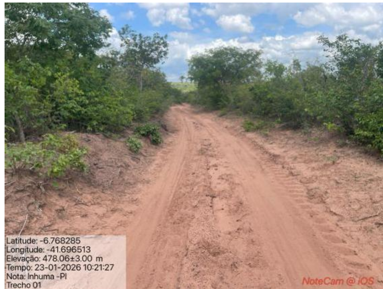
Foto 05: Situação do trecho estrada que sofrerá intervenção
