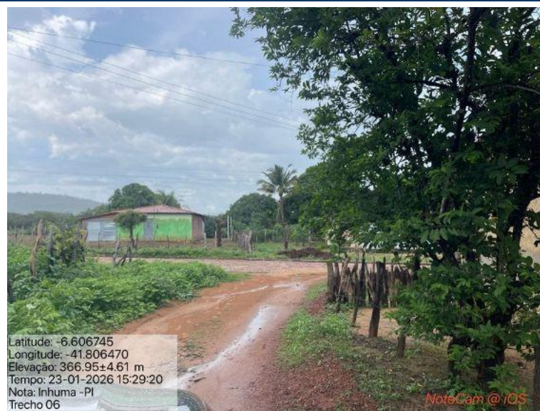
Foto 53: Situação do trecho estrada que sofrerá intervenção
