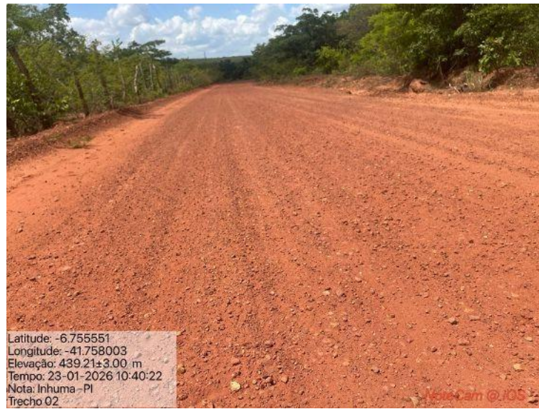
Foto 27: Situação do trecho estrada que sofrerá intervenção
