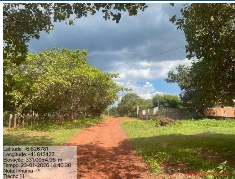
Foto 89: Situação do trecho estrada que sofrerá intervenção
