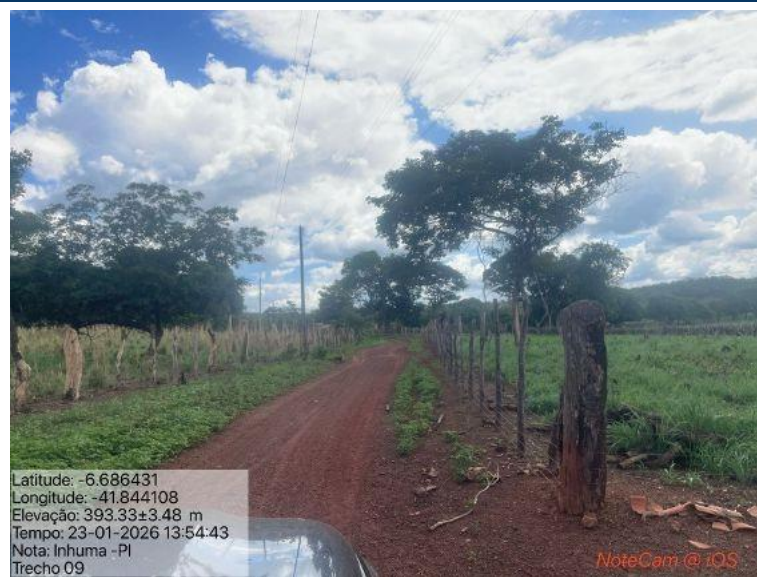
Foto 65: Situação do trecho estrada que sofrerá intervenção
