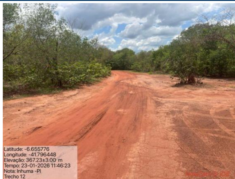
Foto 102: Situação do trecho estrada que sofrerá intervenção
