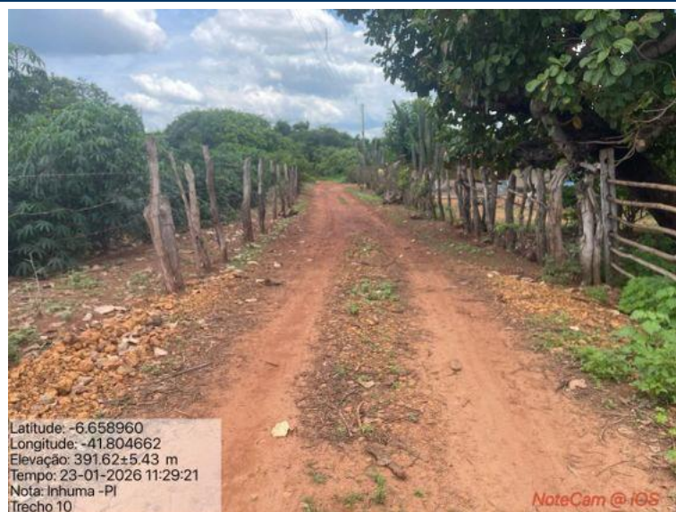
Foto 77: Situação do trecho estrada que sofrerá intervenção
