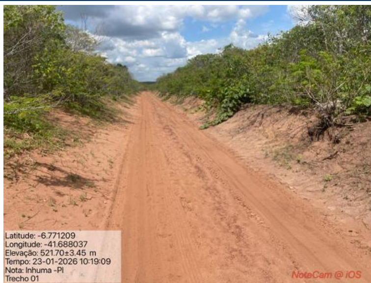
Foto 02: Situação do trecho estrada que sofrerá intervenção
