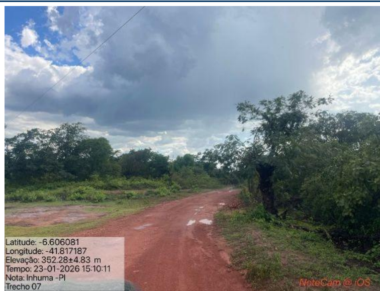
Foto 59: Situação do trecho estrada que sofrerá intervenção
