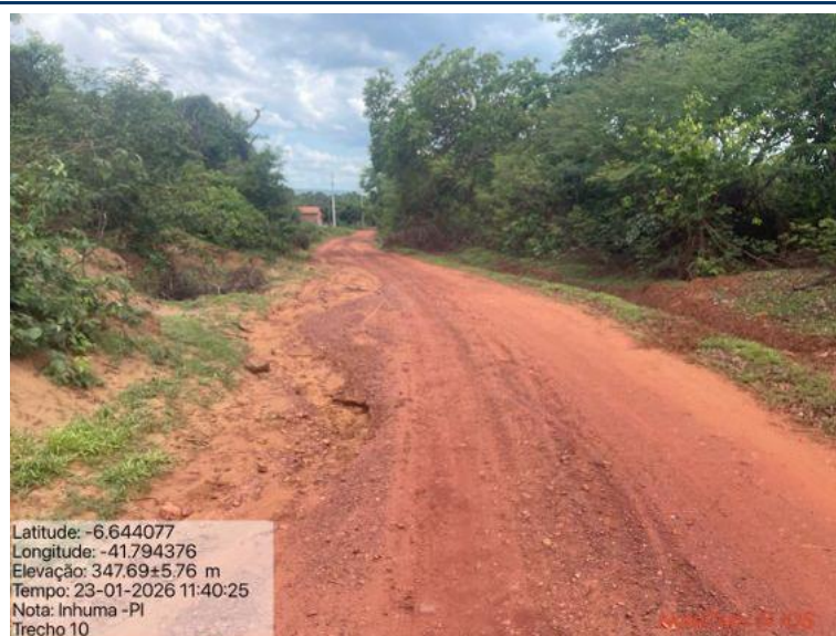
Foto 81: Situação do trecho estrada que sofrerá intervenção
