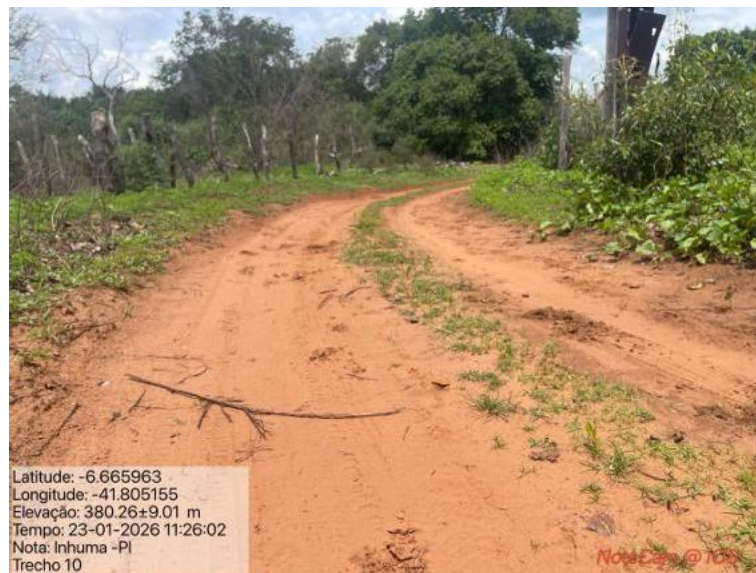
Foto 72: Situação do trecho estrada que sofrerá intervenção
