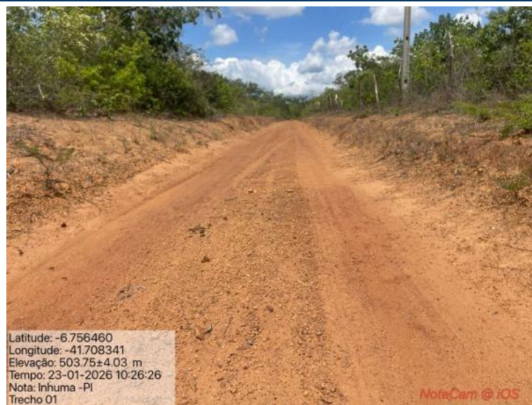
Foto 11: Situação do trecho estrada que sofrerá intervenção
