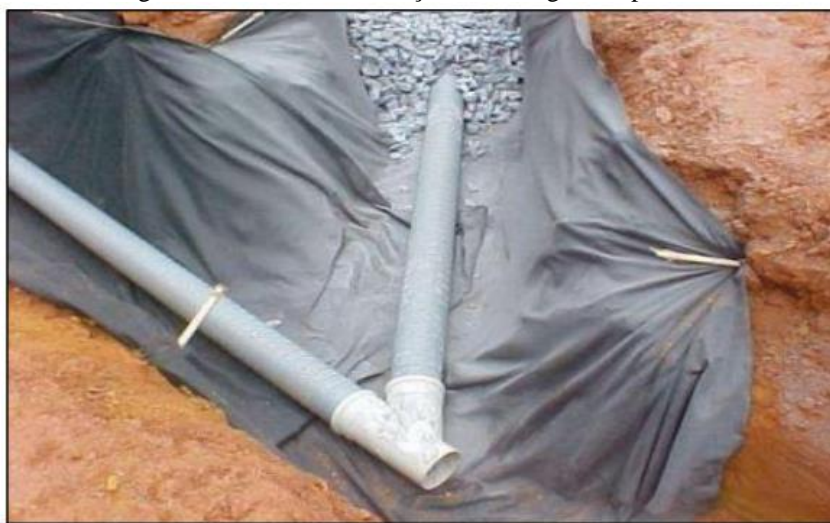
Figura 3- Modelo da instalação da drenagem de percolado
