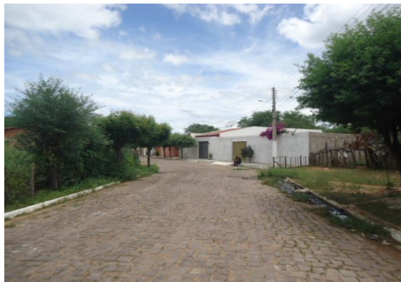
FOTO Nº 02 - REFORMA DO SES
