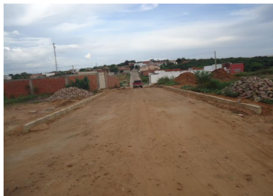
FOTO Nº 04 - REFORMA DO SES
