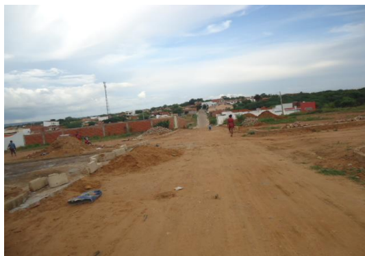
FOTO Nº 02 - REFORMA DO SES
