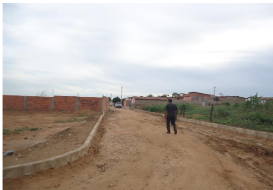
FOTO Nº 01 -REFORMA DO SES
