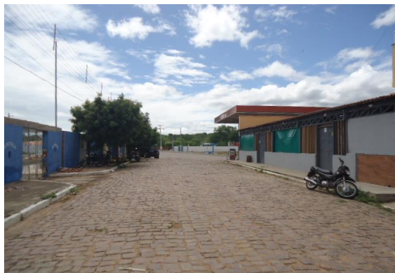
FOTO Nº 01 - REFORMA DO SES
