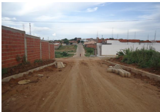
FOTO Nº 05 - REFORMA DO SES
