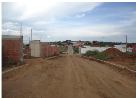
FOTO Nº 03 -REFORMA DO SES
