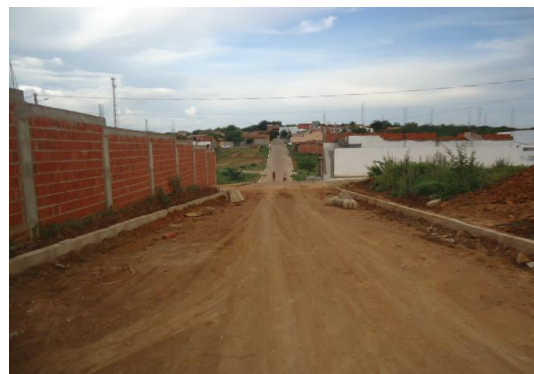
FOTO Nº 06 - REFORMA DO SES
