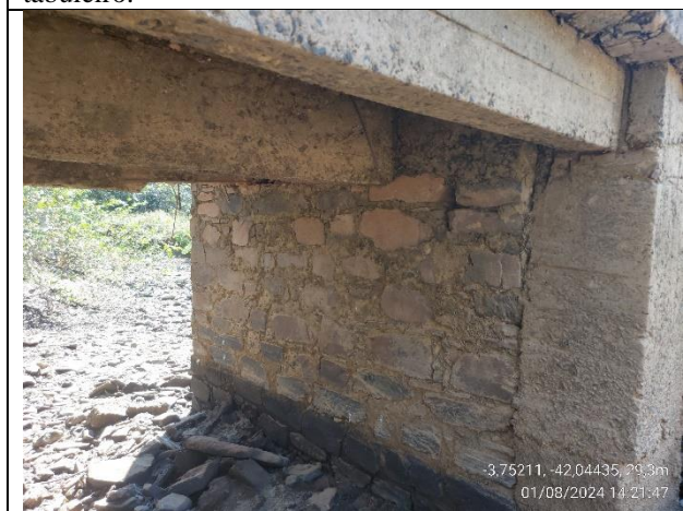
Vista do reforço em concreto executado na base intermediária;
