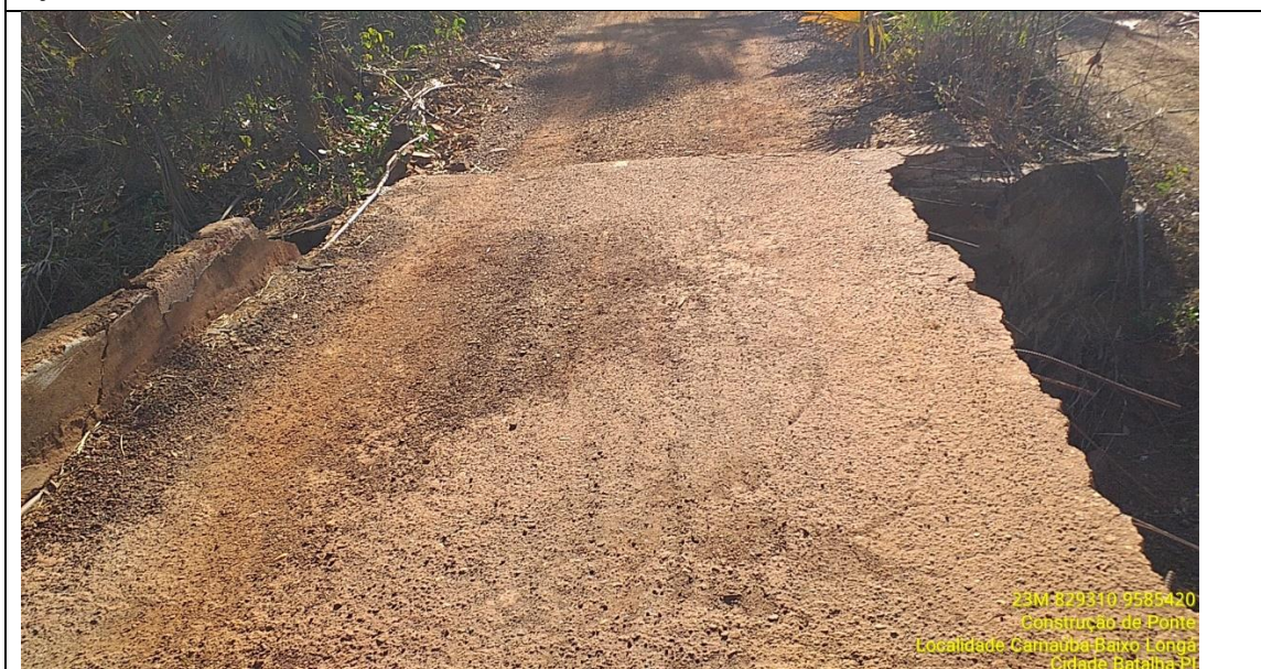
Concreto apresentando desagregação, com redução da espessura da laje;
