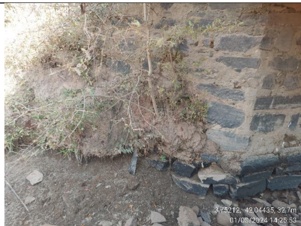
Base de pedra com desagregação da estrutura no leito do riacho;
