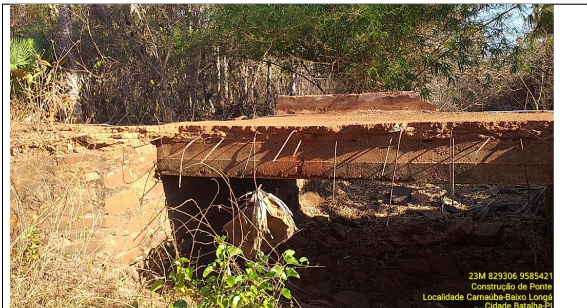
Ruptura da laje do tabuleiro, com desagregação do concreto, baixa densidade na área de armaduras da laje;
