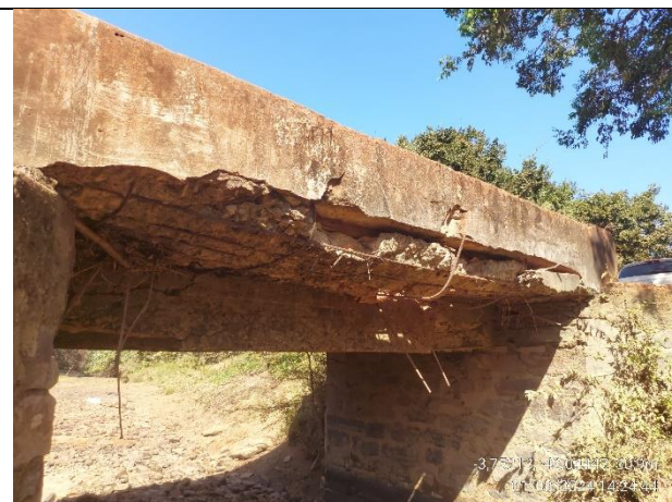
Laje do tabuleiro apresenta colapso estrutural em algumas áreas provocados pela oxidação total da ferragem;
