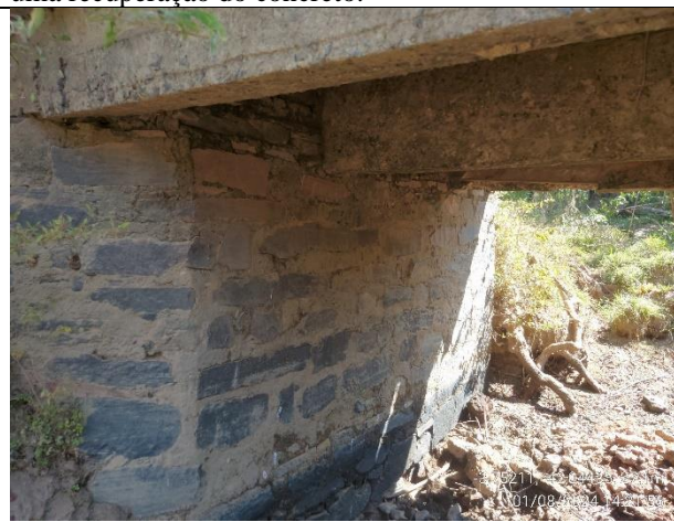
Base de sustentação das vigas e contenção do aterro da estrada;
