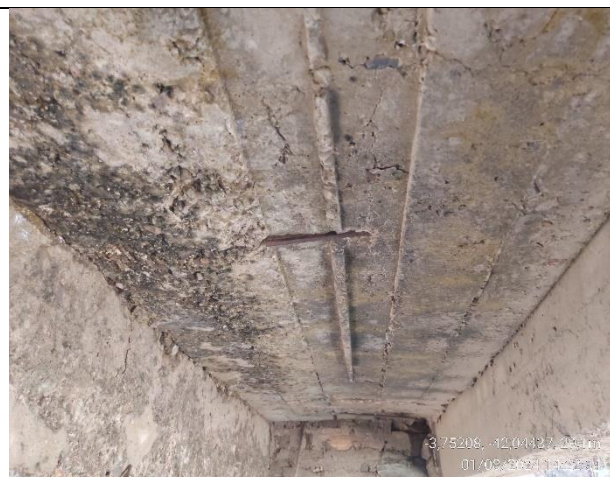
Vista de parte da laje tabuleiro na qual foi executada uma recuperação do concreto.
