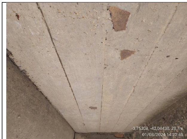
Vista de parte da laje tabuleiro na qual foi executada uma recuperação do concreto.
