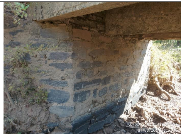
Vista da base de pedra. As vigas longarinas se apoiam diretamente sobre a base de pedra;
