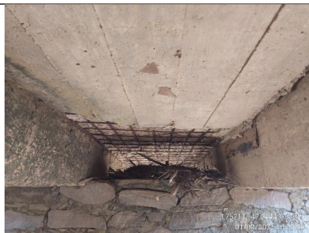
Vista do apoio das vigas longarinas na base de pedra intermediária;
