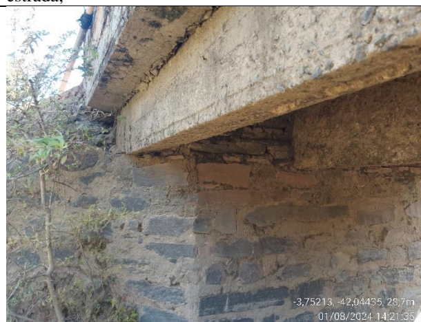
Vista do apoio da viga longarina na base de pedra do lado do povoado;
