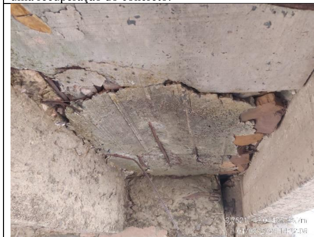
Marcas de concretagem de ruptura anterior da laje do tabuleiro.
