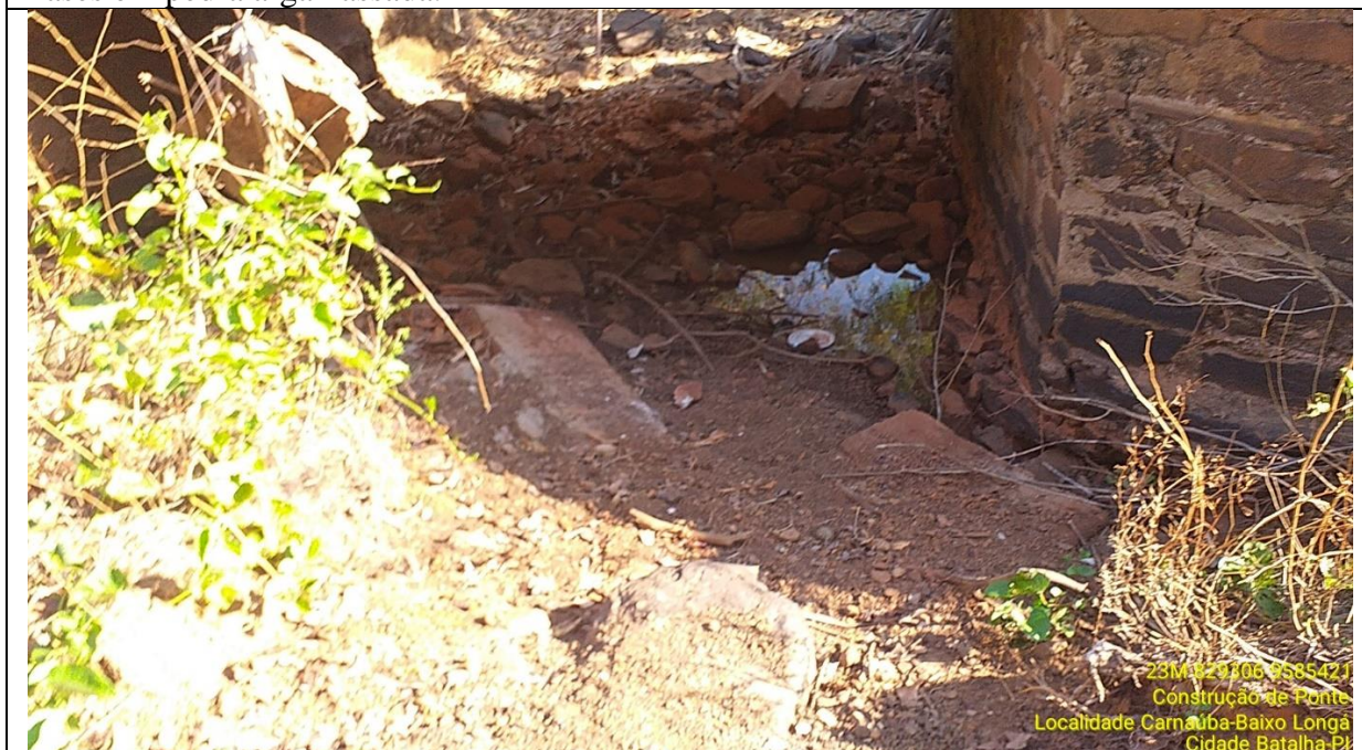
Vista do apoio da cabeceira no sentido da localidade Carnaúba. Apresenta desagregação na base da estrutura;
