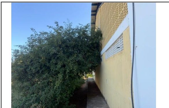
Foto 5: CONSTRUÇÃO DO MURO
