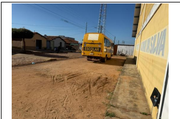
Foto 1: CONSTRUÇÃO DO MURO
