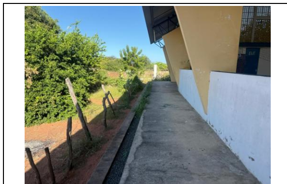
Foto 6: CONSTRUÇÃO DO MURO
