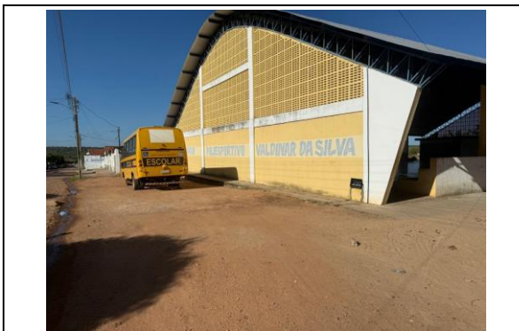
Foto 3: CONSTRUÇÃO DO MURO
