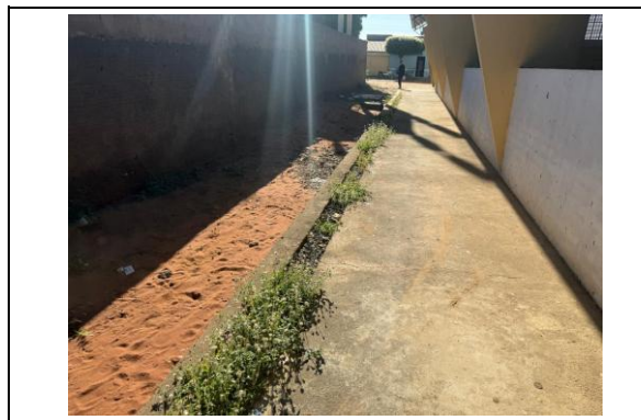
Foto 7: CONSTRUÇÃO DO MURO
