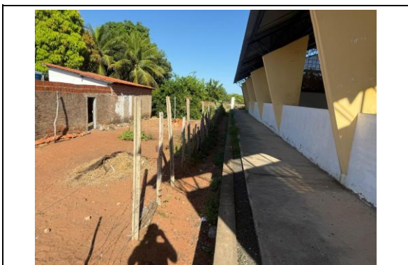
Foto 8: CONSTRUÇÃO DO MURO
