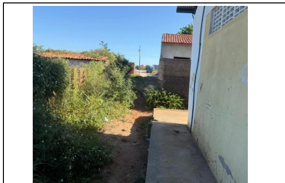
Foto 4: CONSTRUÇÃO DO MURO
