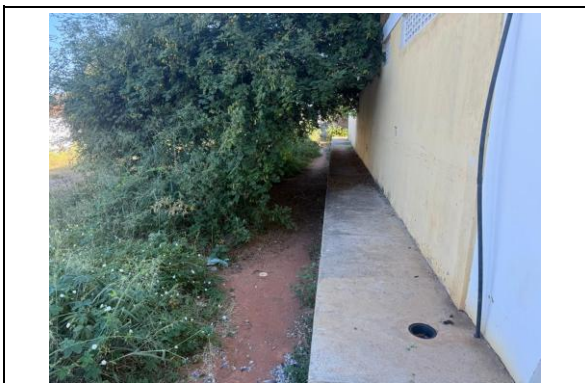
Foto 6: CONSTRUÇÃO DO MURO
