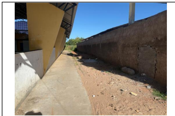
Foto 2: CONSTRUÇÃO DO MURO
