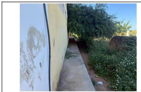
Foto 9: CONSTRUÇÃO DO MURO
