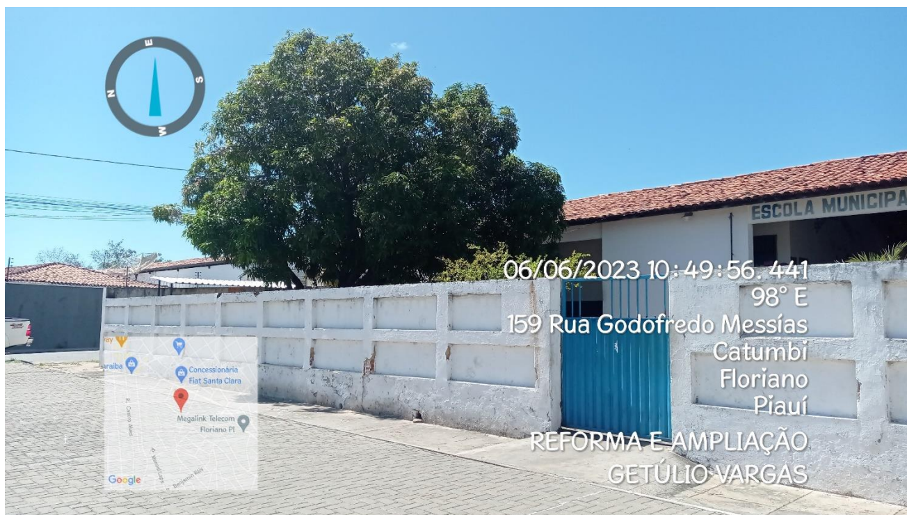
Figura 3: Local a ser executado a obra.
