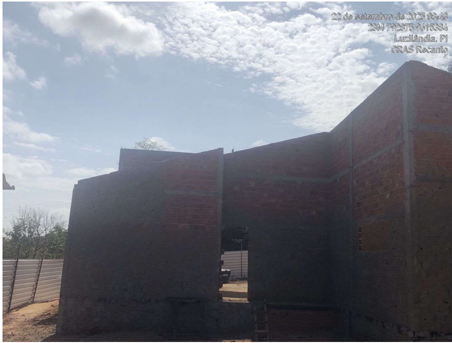
FIGURA 3. FACHADA POSTERIOR DA EDIFICAÇÃO
