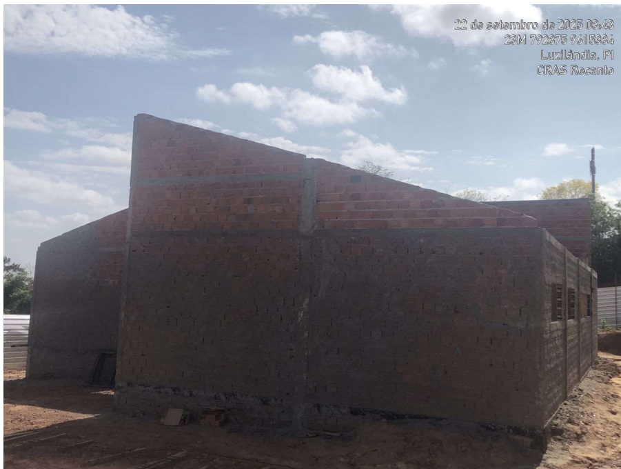
FIGURA 4. FACHADAS POSTERIOR E ESQUERDA DA EDIFICAÇÃO.
