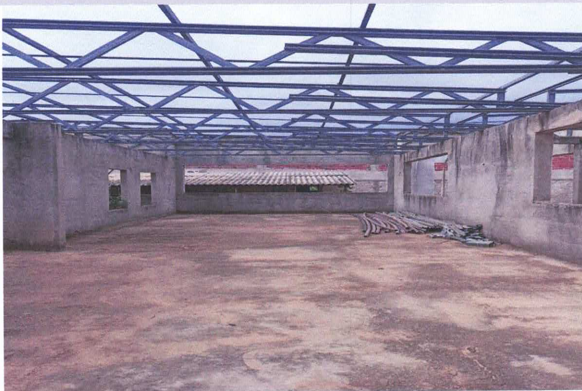
Figura 11 – Estrutura metálica da cobertura. Fonte: elaboração própria
