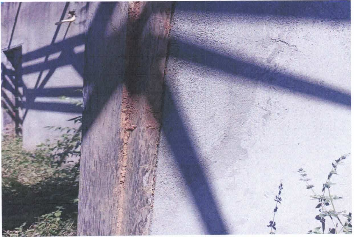
Figura 9 – Marco de madeira com presença de patógenos. Fonte: elaboração própria
