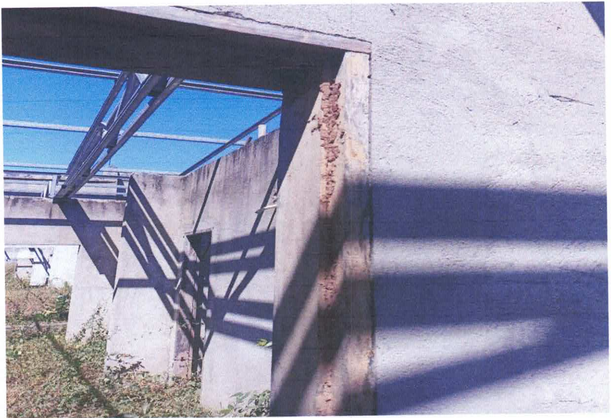
Figura 10 – Marco de madeira com presença de patógeno . Fonte: elaboração própria
