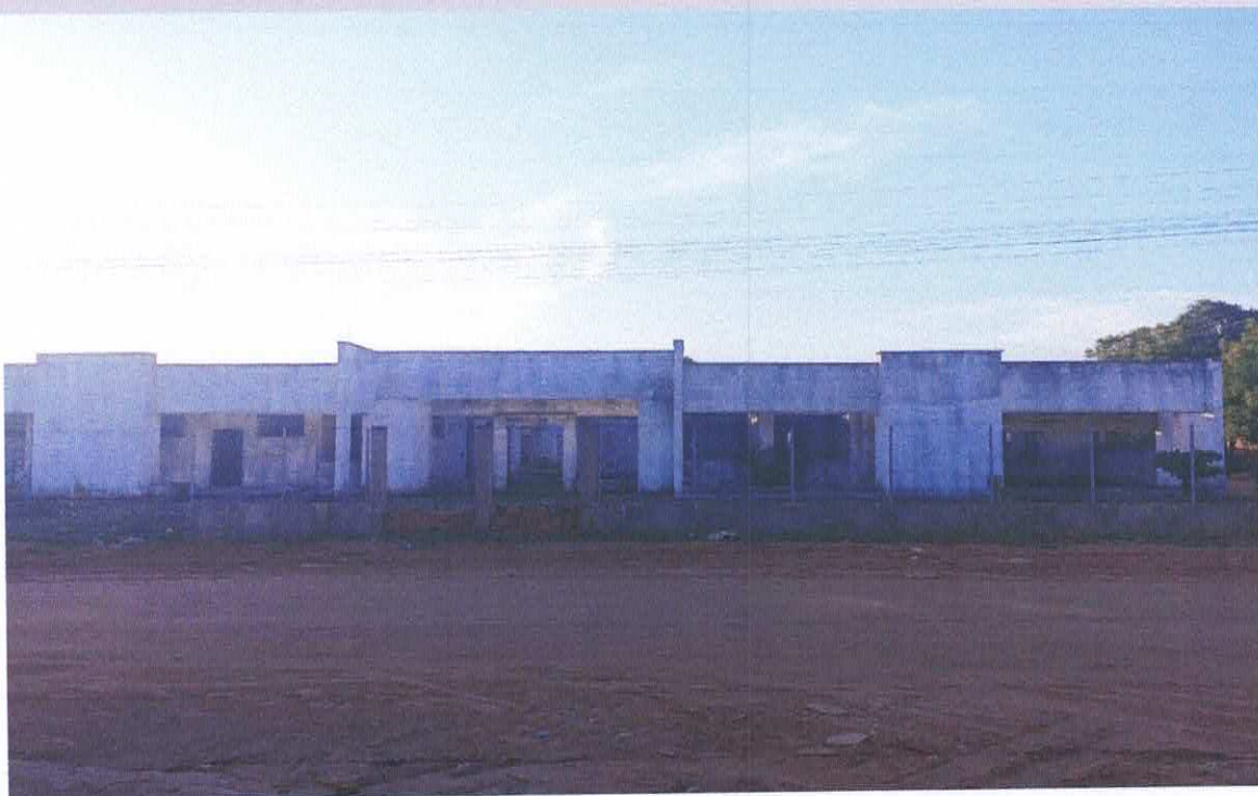
Figura 2 - Vista da entrada principal. Fonte: elaboração própria
