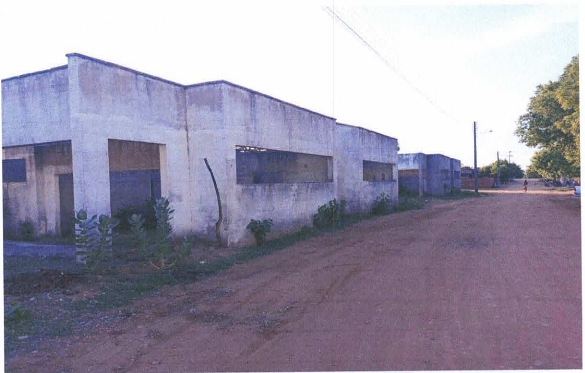
Figura 4 – Vista lateral direita da construção. Fonte: elaboração própria
