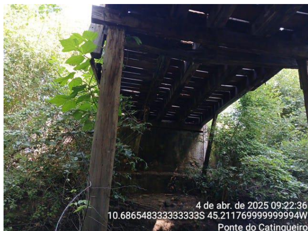
VISTA LONGARINAS – PONTE DO CATINGUEIRO
