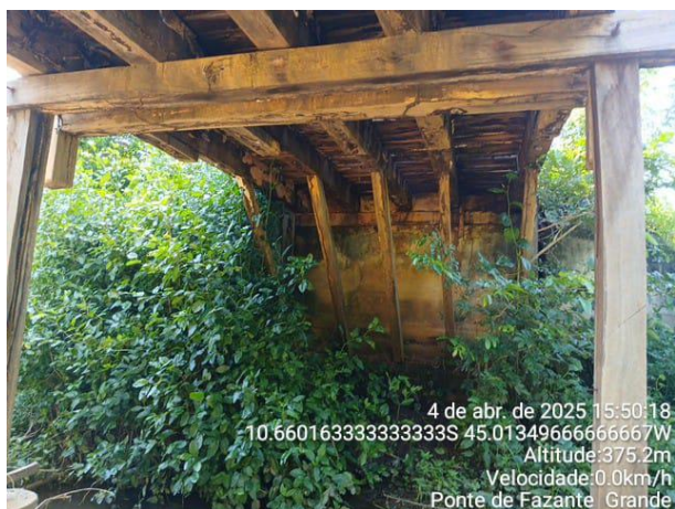
VISTA LONGARINAS - PONTE VAZANTE GRANDE
