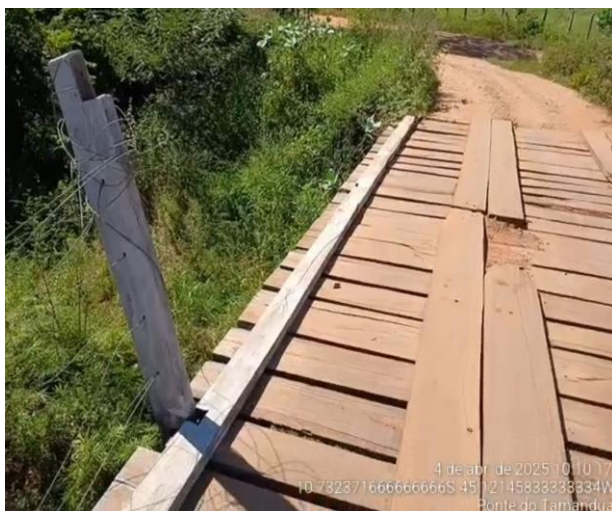
PONTE DE MADEIRA LOCALIDADE TAMANDUÁ
