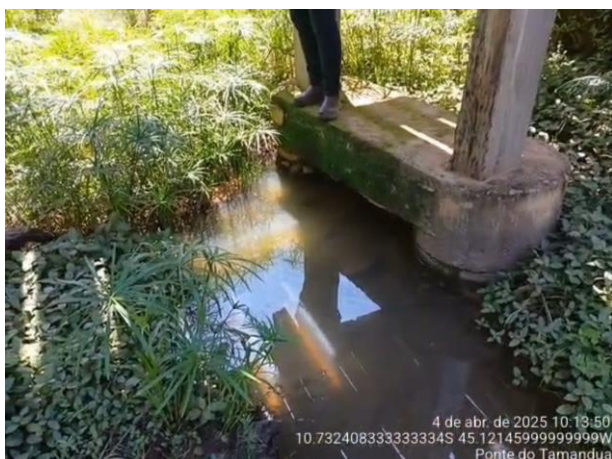
VISTA BLOCO DE ANCORAGEM PILAR
