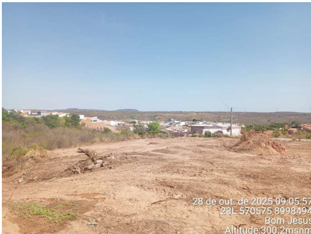
FOTO 14 – LOTE 01 – RUA 19 A CONSTRUIR PARA O CENTRO DO TERRENO
