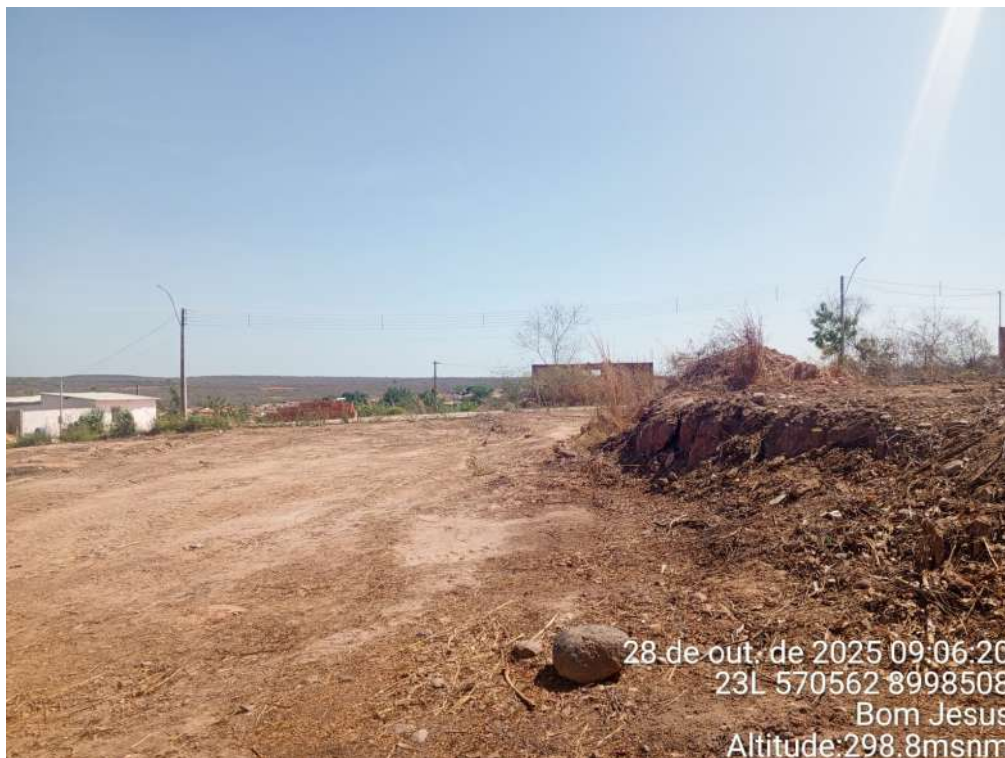
FOTO 13 – LOTE 01 – RUA 19 A CONSTRUIR PARA O CENTRO DO TERRENO
