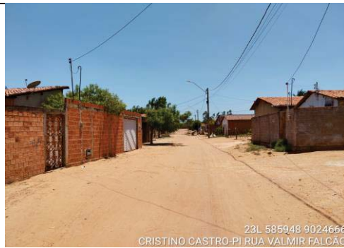
FOTO Nº 8 - RUA VALMIR FALÇÃO TRECHO 1
