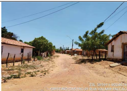
FOTO Nº 11 - RUA VALMIR FALÇÃO TRECHO 1
