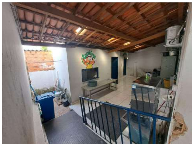
FOTO 05: ACESSO NÍVEL INFERIOR
