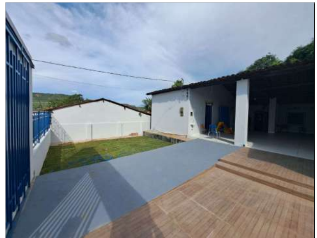
FOTO 02: ENTRADA DA EDIFICAÇÃO
