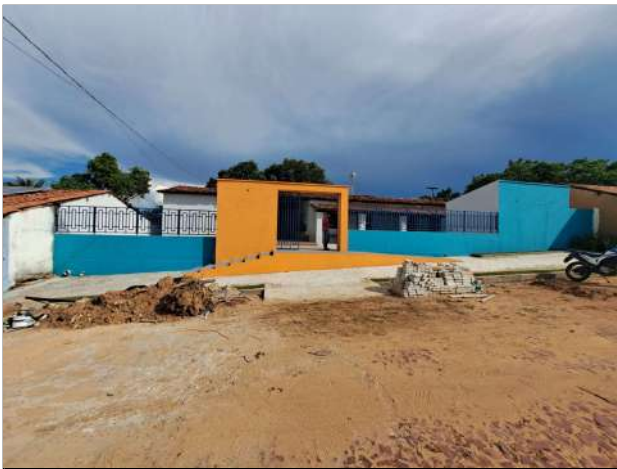
FOTO 01: FACHADA DO IMÓVEL
