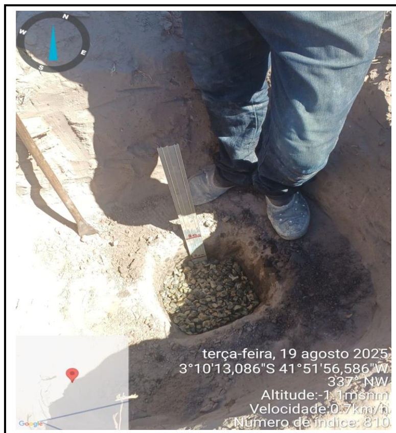
Foto 03: Vala Pronta para Execução.
