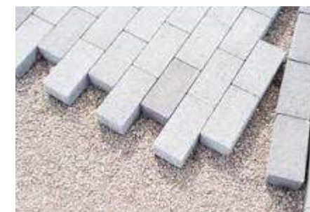
bloque de cimento em substituição pedra portuguesa existente.
