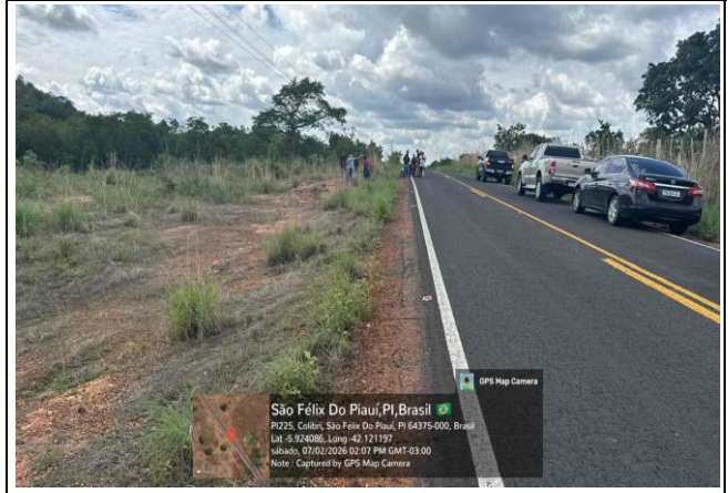
FOTO Nº 2 - LOCAL PARA CONSTRUÇÃO DO PORTAL DE ENTRADA
