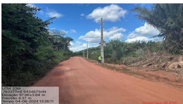
FOTO 03 - LOCAL DA PAVIMENTAÇÃO
