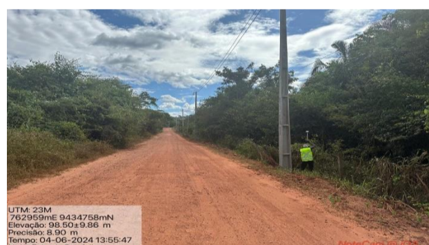
FOTO 04 - LOCAL DA PAVIMENTAÇÃO
