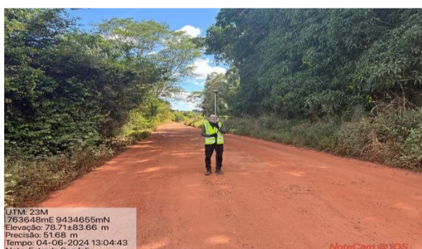
FOTO 05 - LOCAL DA PAVIMENTAÇÃO
