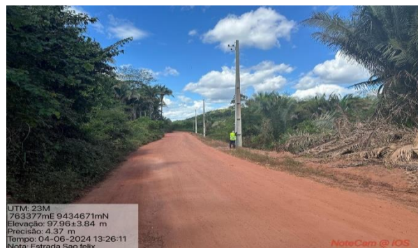
FOTO 06 - LOCAL DA PAVIMENTAÇÃO
