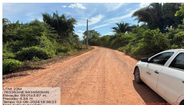
FOTO 02 - LOCAL DA PAVIMENTAÇÃO
