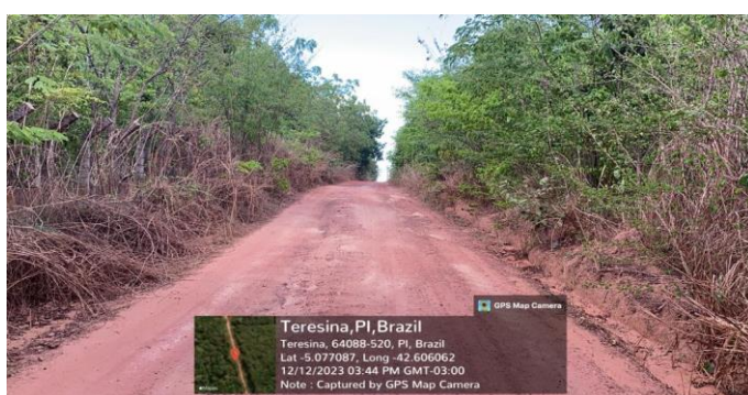
FOTO 05 - LOCAL DA PAVIMENTAÇÃO
