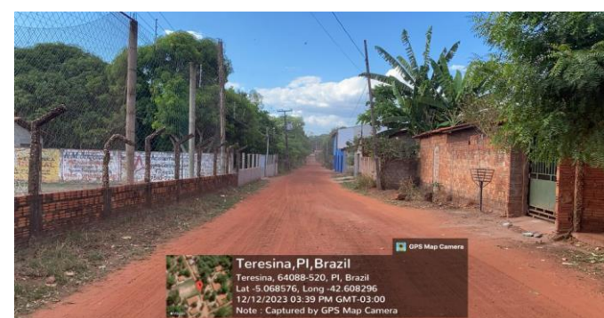
FOTO 04 - LOCAL DA PAVIMENTAÇÃO
