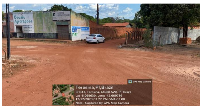
FOTO 02 - LOCAL DA PAVIMENTAÇÃO
