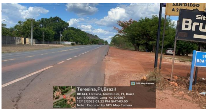
FOTO 01 - LOCAL DA PAVIMENTAÇÃO
