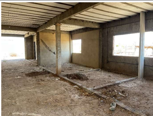
Fig. 9 – Execução de paredes, estrutura e instalações pluviais
