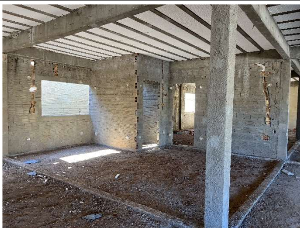
Fig. 7 – Execução de superestrutura e alvenaria
