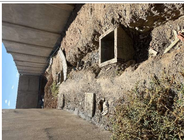
Fig. 16 – Caixas de passagem – instalações elétricas/pluviais/lógicas
