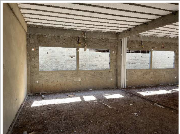
Fig. 10 – Execução de paredes, estrutura e instalações pluviais
