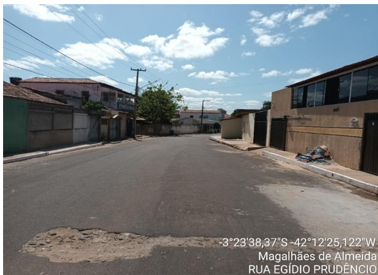
RUA EGÍDIO PRUDÊNCIO TRECHO 01
