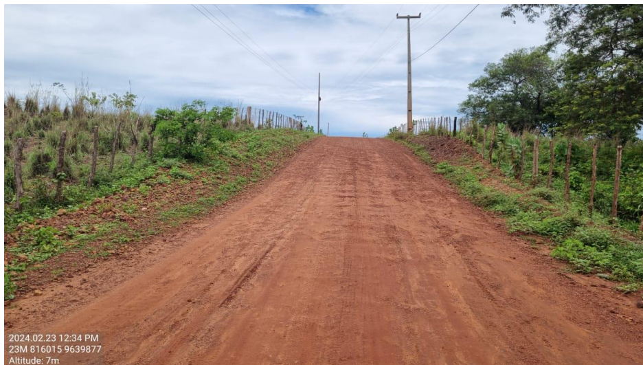
FOTO 1 – INÍCIO DO TRECHO 1
