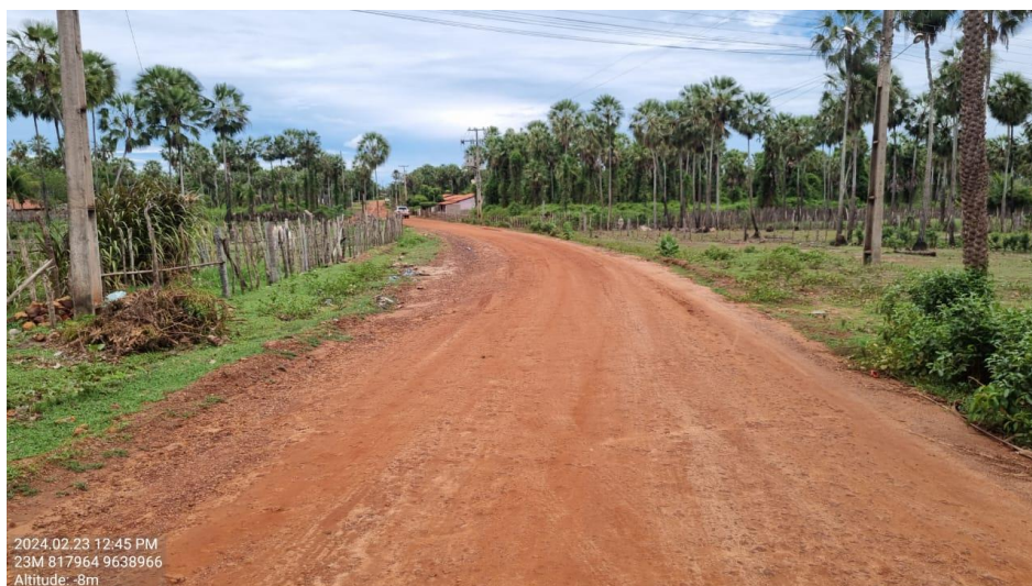
FOTO 1 – INÍCIO DO TRECHO 2
