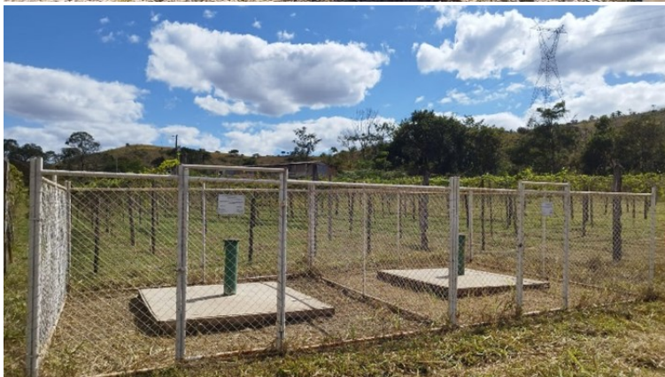
Figura 1 - Poço de monitoramento
