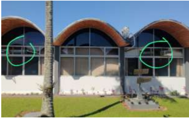
Fig.09. Vista da área externa das salas ( 41 e 44) deverão ser retirados os aparelhos de ar condicionado e o fechamento com vidros.
