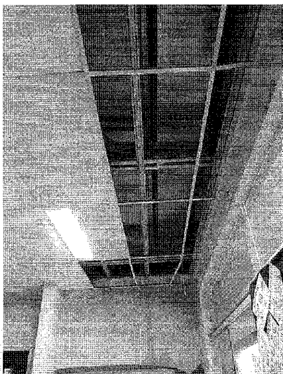
Figuras 19 e 20: Forro caído. Fonte elaboração própria.
