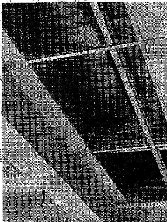
Figuras 9 e 10: Calha sendo nivelada com auxílio de tijolo e isopor. Fonte: elaboração própria.
