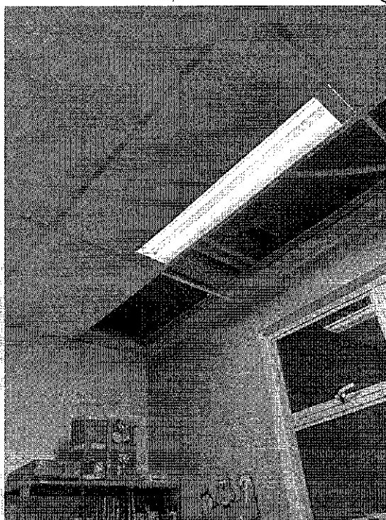
Figuras 43 e 44: Forro caído. Fonte: elaboração própria.
