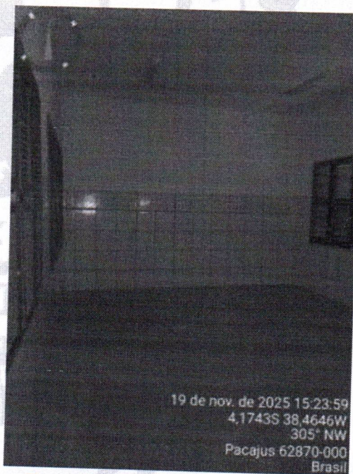
Figura 6: Sala em estado preservado.
