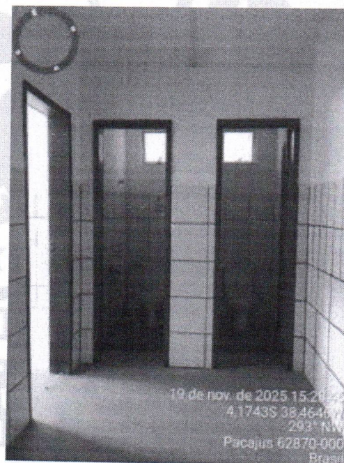
Figura 14: Banheiros do pátio.
