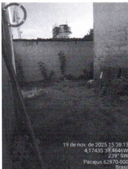
Figura 23: Terraço situado aos fundos da edificação.
