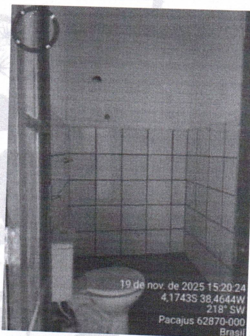
Figura 2: Banheiro em condições satisfatórias de conservação.
