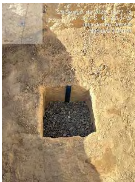
Figura 4 – Execução da cavidade para o ensaio de infiltração
