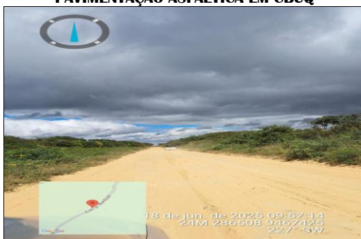
PAVIMENTAÇÃO ASFÁLTICA EM CBUQ
