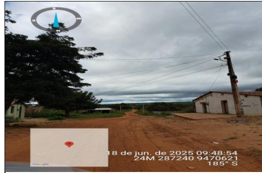
PAVIMENTAÇÃO ASFÁLTICA EM CBUQ
