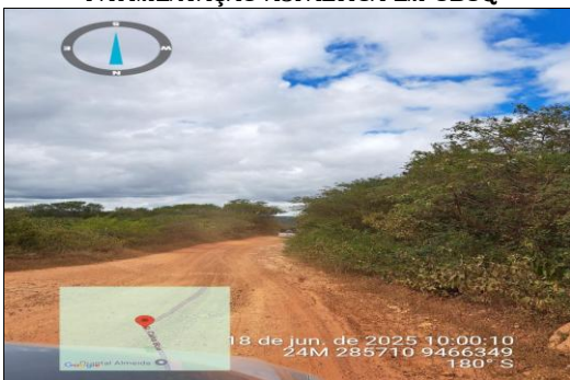
PAVIMENTAÇÃO ASFÁLTICA EM CBUQ
