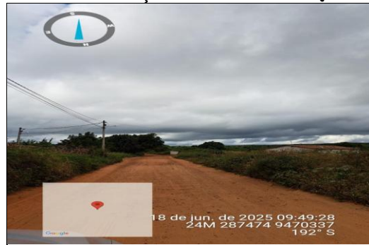
PAVIMENTAÇÃO ASFÁLTICA EM CBUQ
