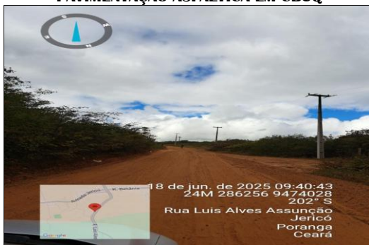
PAVIMENTAÇÃO ASFÁLTICA EM CBUQ
