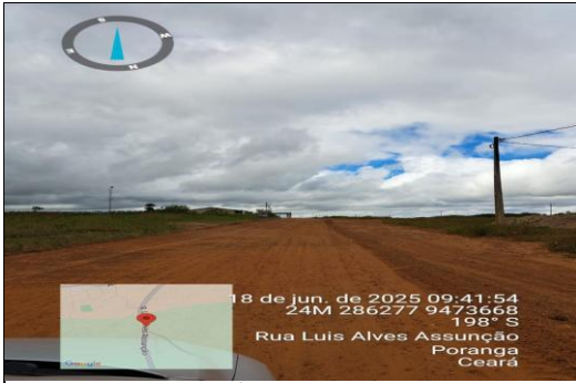
PAVIMENTAÇÃO ASFÁLTICA EM CBUQ
