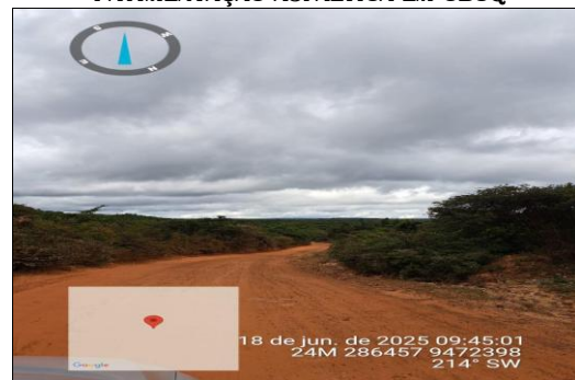
PAVIMENTAÇÃO ASFÁLTICA EM CBUQ
