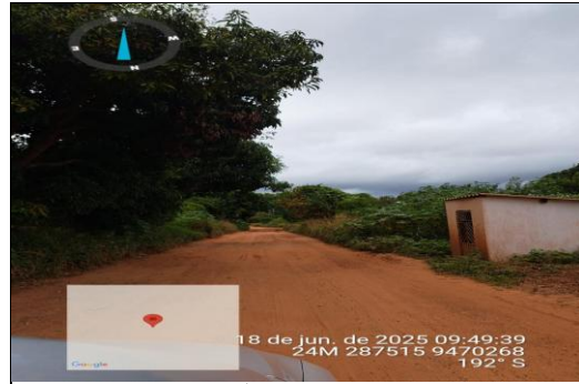
PAVIMENTAÇÃO ASFÁLTICA EM CBUQ
