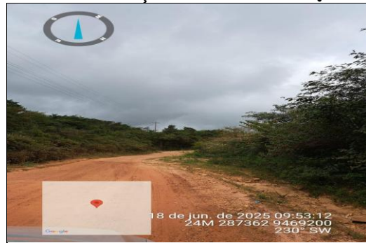
PAVIMENTAÇÃO ASFÁLTICA EM CBUQ
