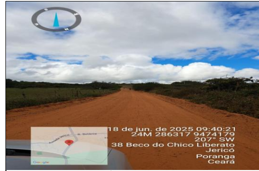
PAVIMENTAÇÃO ASFÁLTICA EM CBUQ
