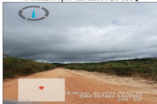
PAVIMENTAÇÃO ASFÁLTICA EM CBUQ
