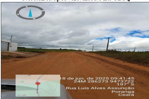
PAVIMENTAÇÃO ASFÁLTICA EM CBUQ
