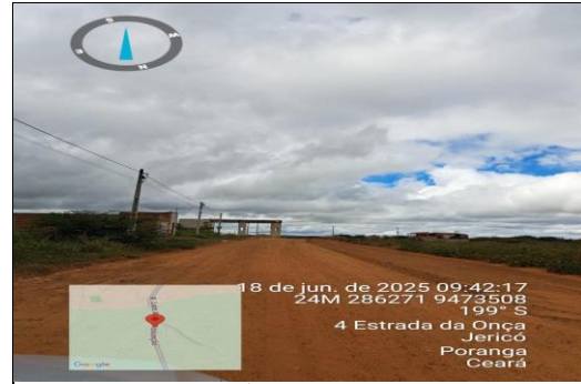
PAVIMENTAÇÃO ASFÁLTICA EM CBUQ
