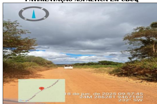
PAVIMENTAÇÃO ASFÁLTICA EM CBUQ
