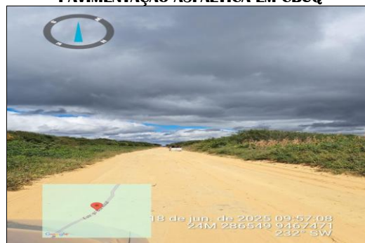
PAVIMENTAÇÃO ASFÁLTICA EM CBUQ
