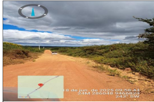
PAVIMENTAÇÃO ASFÁLTICA EM CBUQ
