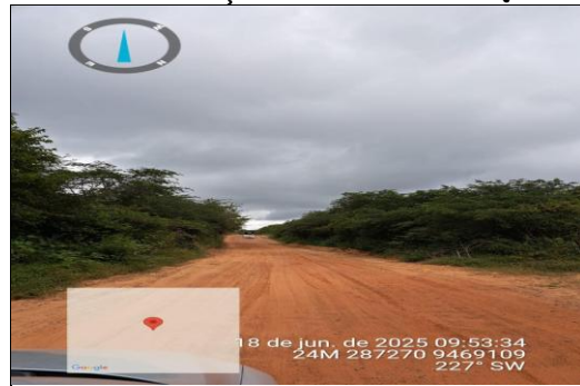
PAVIMENTAÇÃO ASFÁLTICA EM CBUQ
