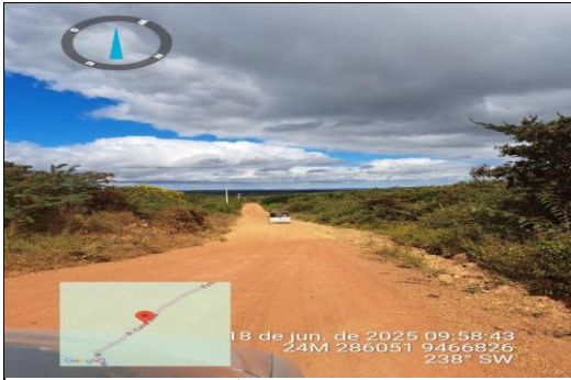
PAVIMENTAÇÃO ASFÁLTICA EM CBUQ
