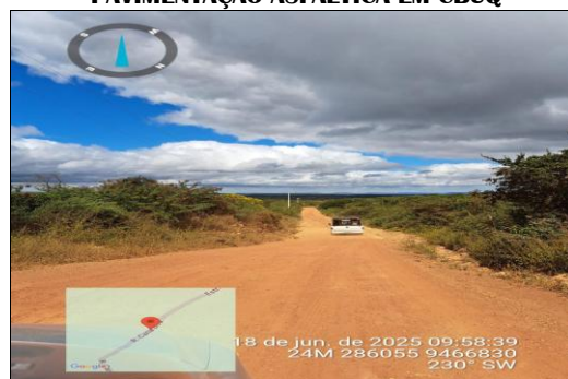
PAVIMENTAÇÃO ASFÁLTICA EM CBUQ
