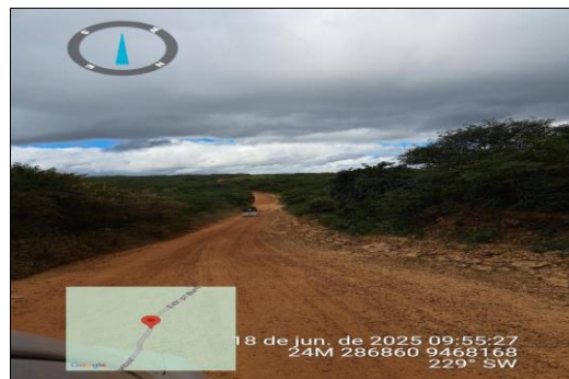
PAVIMENTAÇÃO ASFÁLTICA EM CBUQ
