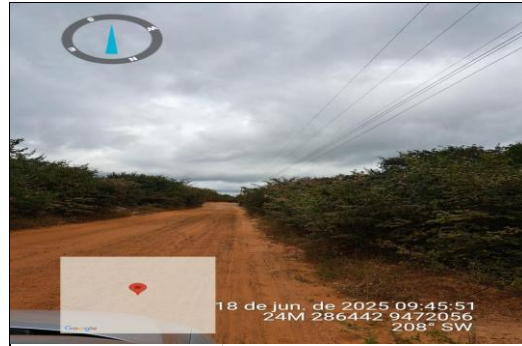
PAVIMENTAÇÃO ASFÁLTICA EM CBUQ
