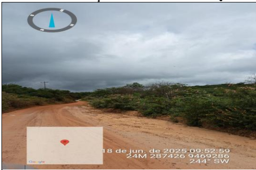
PAVIMENTAÇÃO ASFÁLTICA EM CBUQ
