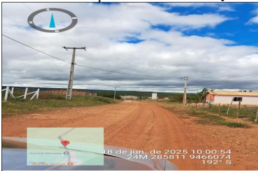
PAVIMENTAÇÃO ASFÁLTICA EM CBUQ
