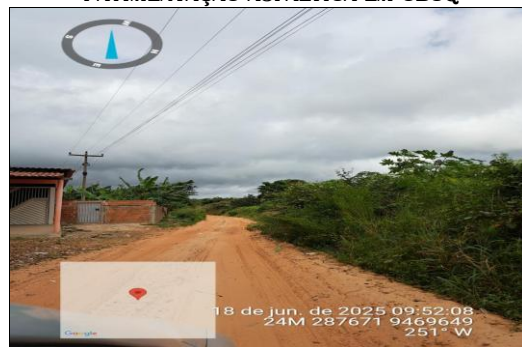
PAVIMENTAÇÃO ASFÁLTICA EM CBUQ
