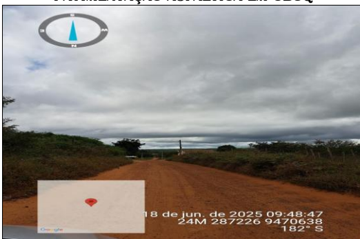
PAVIMENTAÇÃO ASFÁLTICA EM CBUQ
