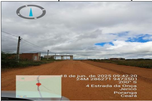
PAVIMENTAÇÃO ASFÁLTICA EM CBUQ
