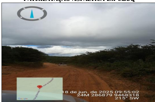
PAVIMENTAÇÃO ASFÁLTICA EM CBUQ
