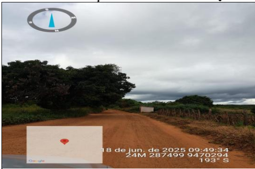
PAVIMENTAÇÃO ASFÁLTICA EM CBUQ
