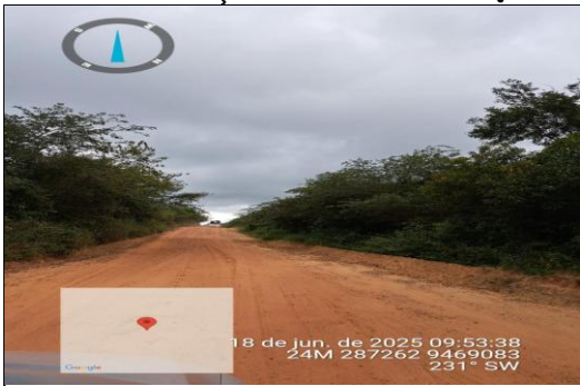
PAVIMENTAÇÃO ASFÁLTICA EM CBUQ
