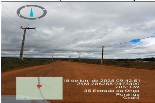
PAVIMENTAÇÃO ASFÁLTICA EM CBUQ
