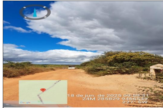
PAVIMENTAÇÃO ASFÁLTICA EM CBUQ
