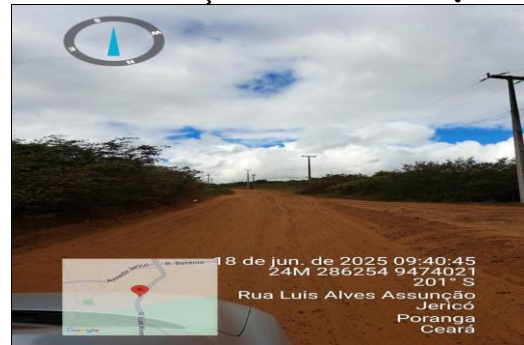
PAVIMENTAÇÃO ASFÁLTICA EM CBUQ
