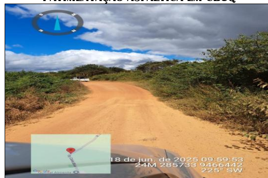
PAVIMENTAÇÃO ASFÁLTICA EM CBUQ
