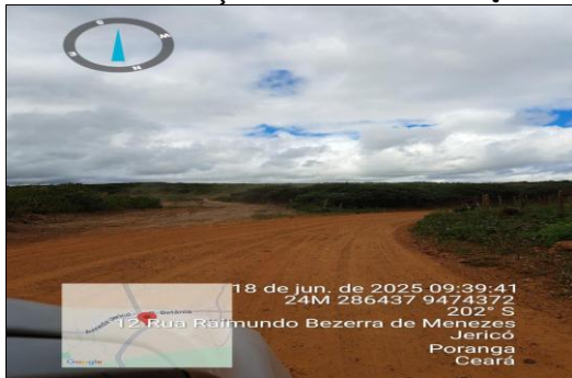
PAVIMENTAÇÃO ASFÁLTICA EM CBUQ
