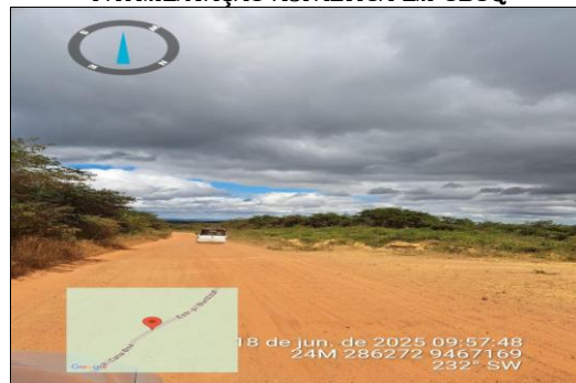
PAVIMENTAÇÃO ASFÁLTICA EM CBUQ
