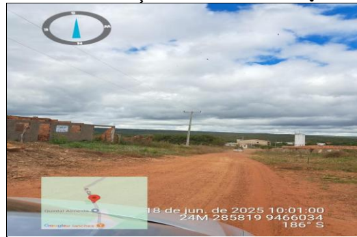
PAVIMENTAÇÃO ASFÁLTICA EM CBUQ
