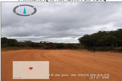
PAVIMENTAÇÃO ASFÁLTICA EM CBUQ
