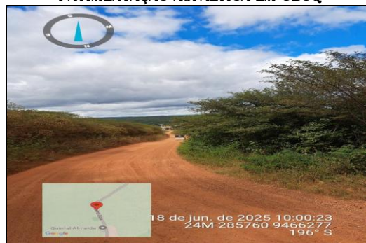
PAVIMENTAÇÃO ASFÁLTICA EM CBUQ
