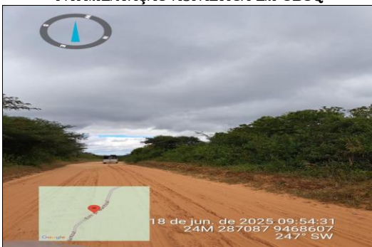
PAVIMENTAÇÃO ASFÁLTICA EM CBUQ
