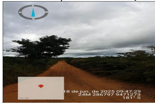
PAVIMENTAÇÃO ASFÁLTICA EM CBUQ
