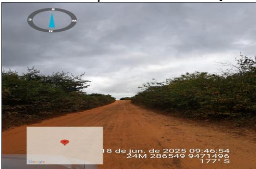
PAVIMENTAÇÃO ASFÁLTICA EM CBUQ
