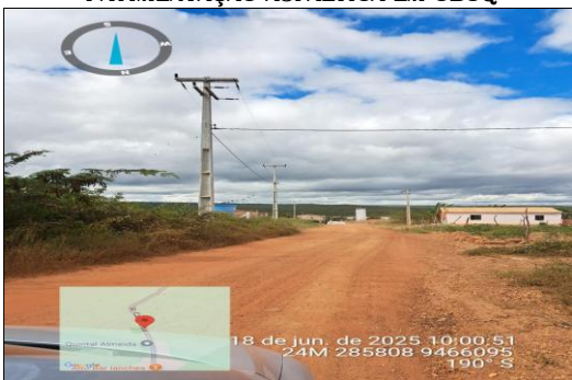
PAVIMENTAÇÃO ASFÁLTICA EM CBUQ
