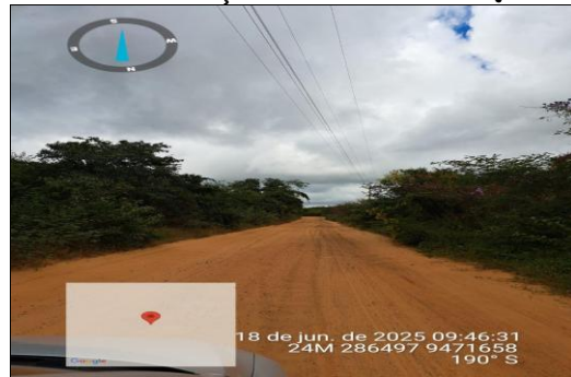
PAVIMENTAÇÃO ASFÁLTICA EM CBUQ
