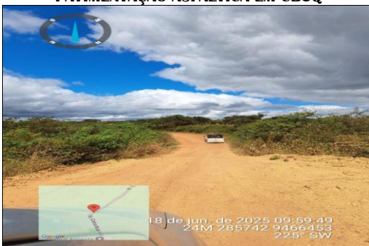
PAVIMENTAÇÃO ASFÁLTICA EM CBUQ
