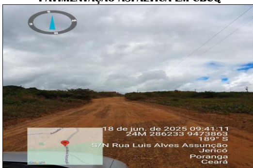
PAVIMENTAÇÃO ASFÁLTICA EM CBUQ
