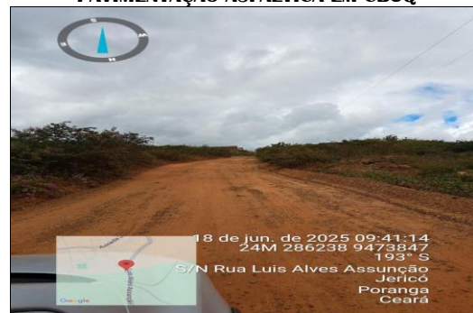
PAVIMENTAÇÃO ASFÁLTICA EM CBUQ
