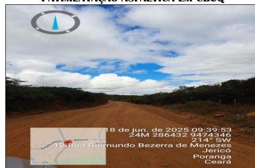
PAVIMENTAÇÃO ASFÁLTICA EM CBUQ
