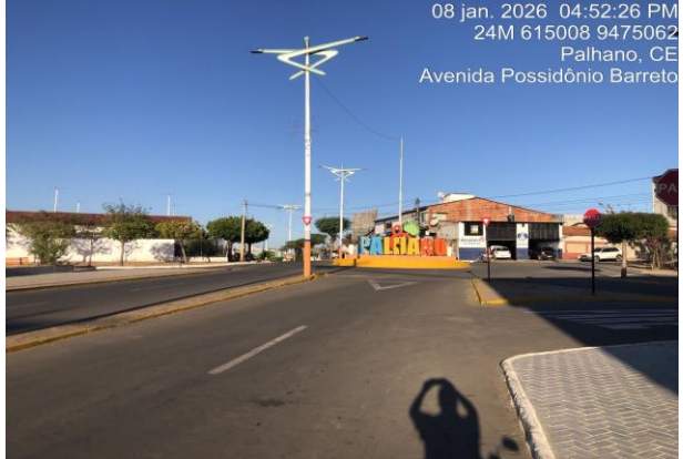
ROTATÓRIA DA AVENIDA
