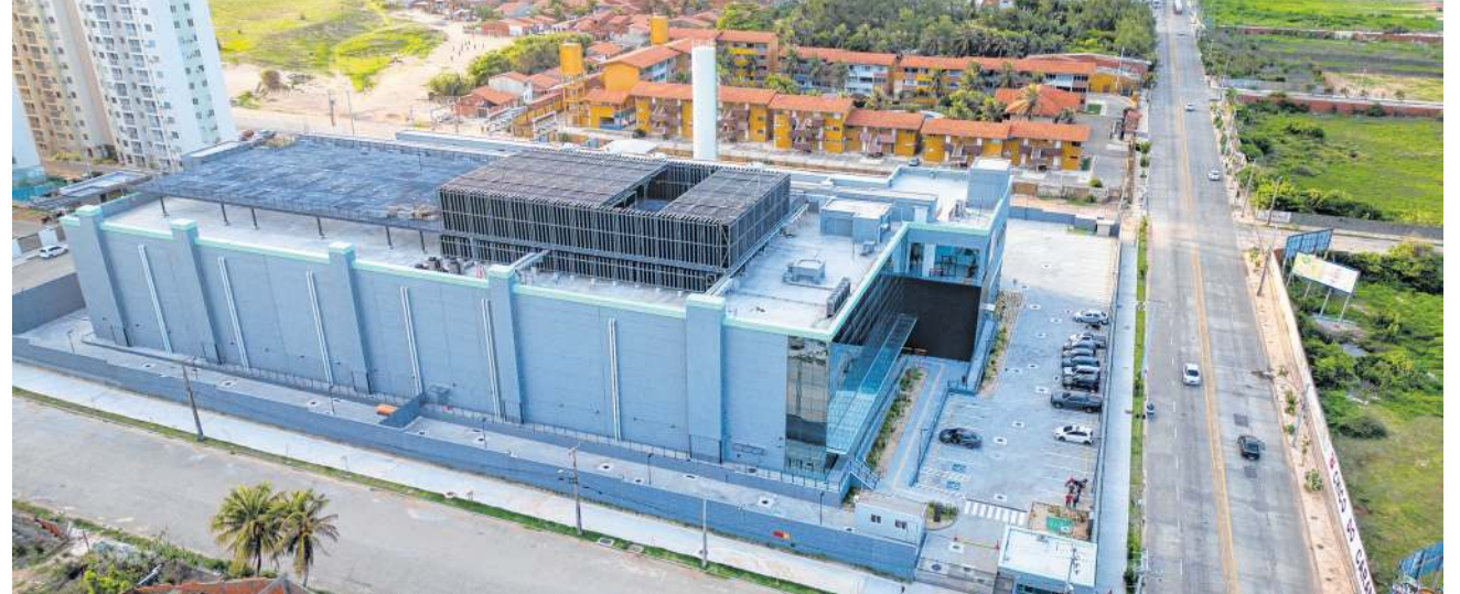
INVESTIMENTO para ampliar de 3 MW para 6 MW de TI será de US$ 30 milhões
