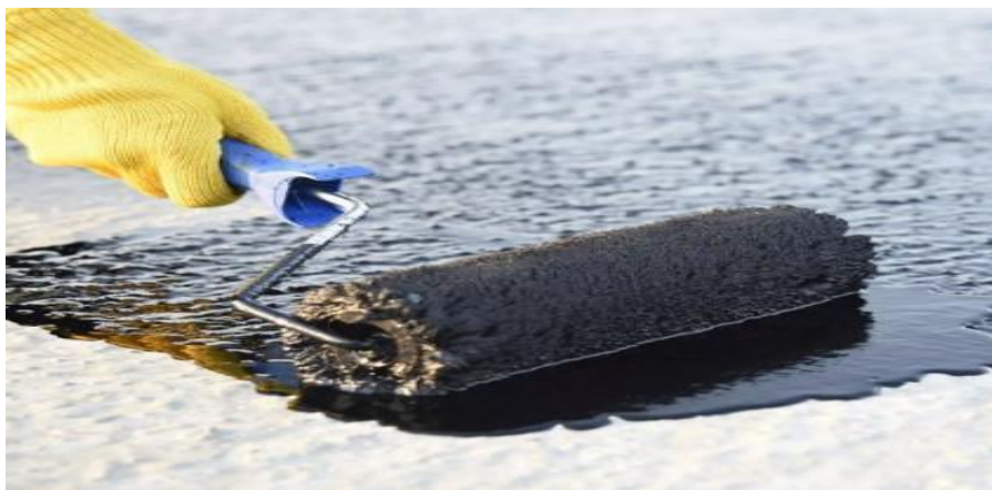
Figura 8: Impermeabilização das Vigas baldrames. Fonte: Caderno de Especificações – Ministério da Saúde
