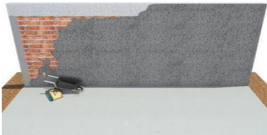
Figura 14: Chapisco nas paredes internas e externas. Fonte: Caderno de Especificações – Ministério da Saúde
